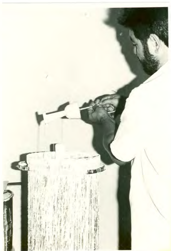
FIGURA 40 - Drenagem da primeira camada de lama cerâmica.
