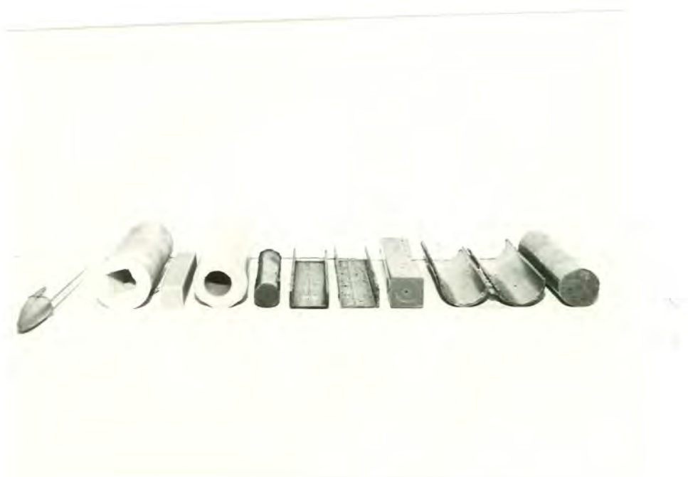
FIGURA 28 - Matrizes usadas na obtenção dos modelos em cera.
