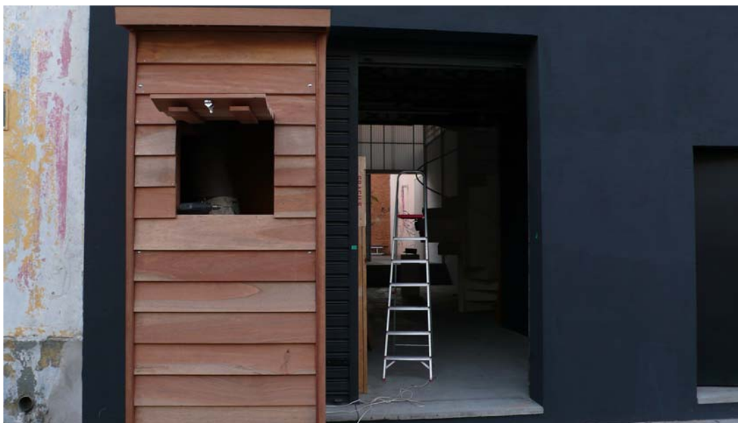
Fig. 90. Guarita Z sendo finalizada na frente do Project Room
