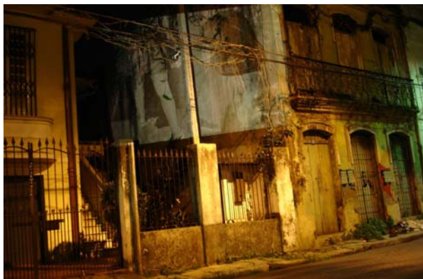
Fig. 70. Projeção realizada em uma casa, Belém, 2005
