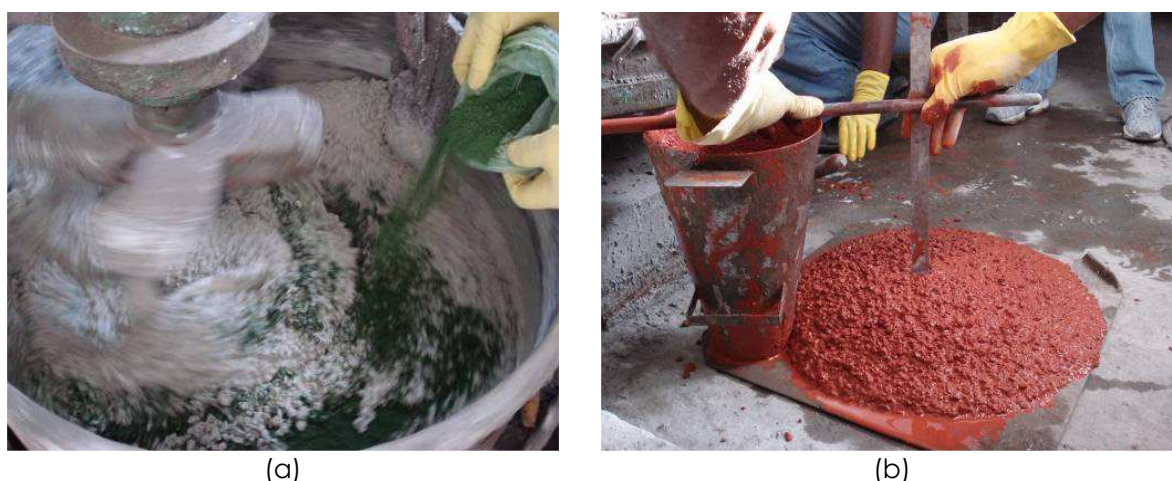
Figura 11 – (a) Mistura dos materiais; (b) Abatimento de tronco de cone ( Slump )
