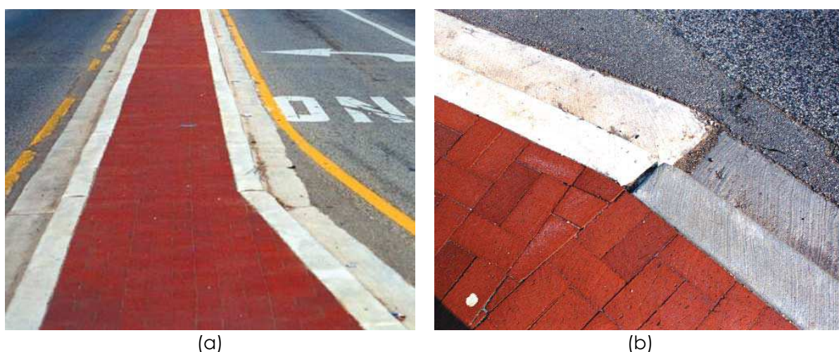
Figura 2 – (a) Passeio central composto por meios-fios brancos e tijolos vermelhos; (b) Diferença acentuada entre os meios-fios cinza e branco [Fonte: PCA, 2002a]
