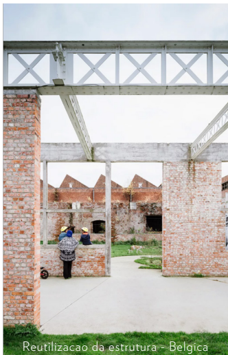
Reutilização da estrutura - Bélgica
