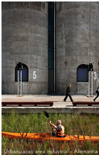
Urbanização área industrial - Alemanha
