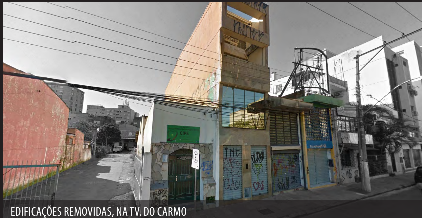
EDIFICAÇÕES REMOVIDAS, TR. DO CARMO
