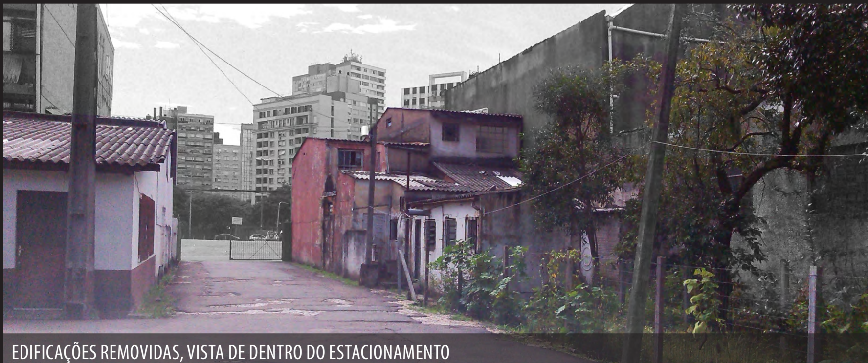
EDIFICAÇÕES REMOVIDAS, VISTA DE DENTRO DO ESTACIONAMENTO
