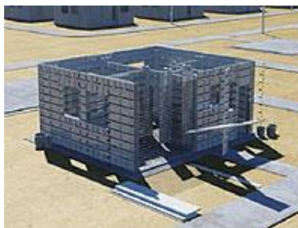
Figura 6 – Fôrma de alumínio para concretagem de paredes em obra
