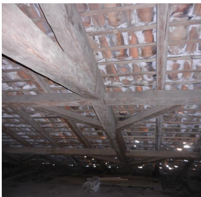
Figura 12 – Telhado do salão visto internamente
