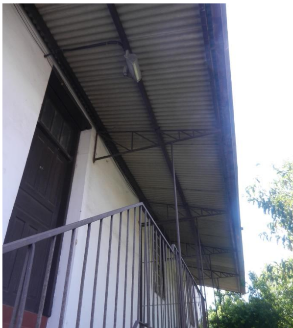
Figura 13 – Telhado não caracterizado
