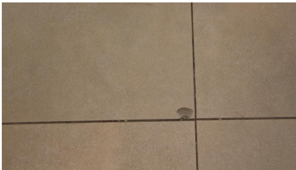
Figura 18 – Lascamento em revestimento de piso com porcelanato natural liso na loja 7
