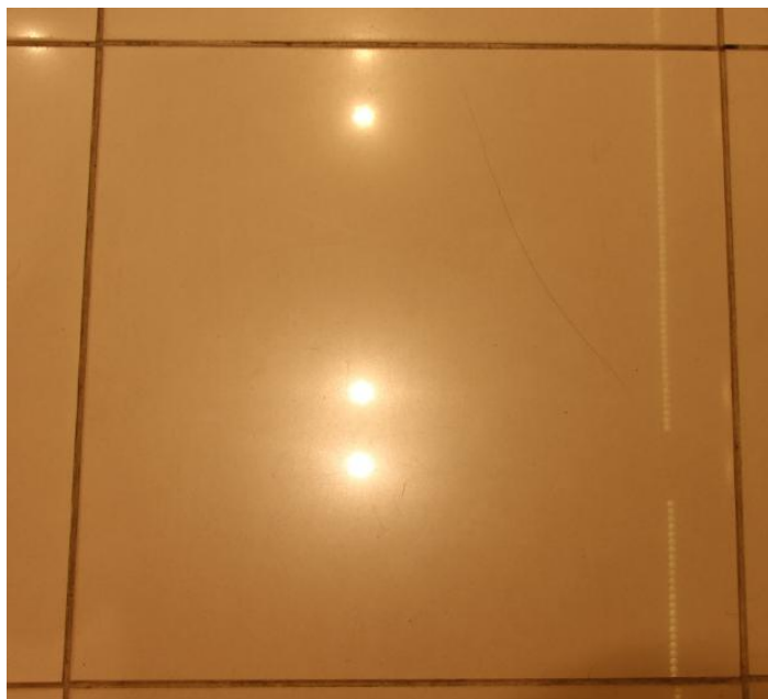
Figura 16 – Riscamento em revestimento de piso com porcelanato polido na loja 36
