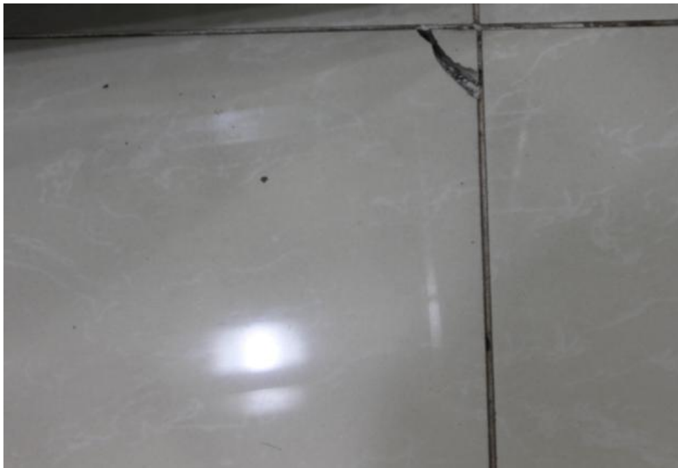
Figura 25 – Ruptura de canto em porcelanato polido na loja 36
