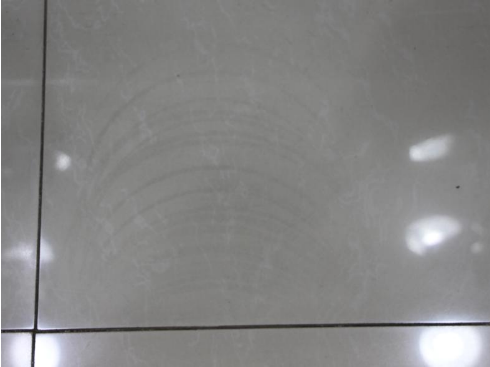
Figura 24 – Manchamento e desgaste no revestimento de piso com porcelanato polido na loja 14
