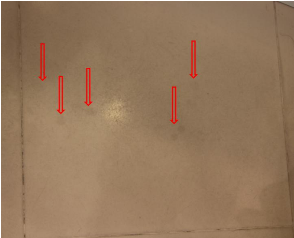
Figura 24 – Manchamento e desgaste no revestimento de piso com porcelanato polido na loja 14
