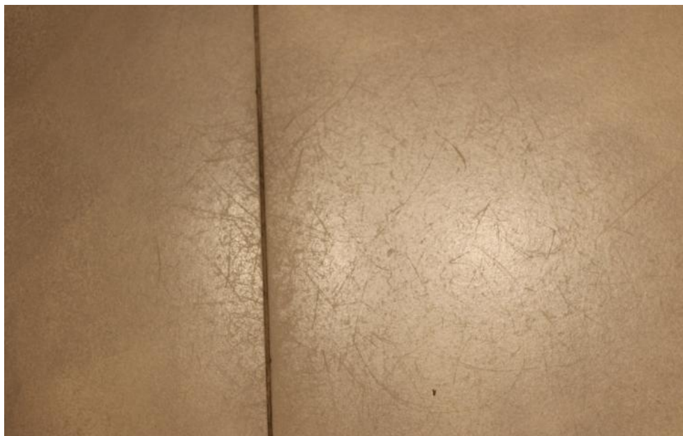
Figura 17 – Riscos e desgaste em revestimento de piso com porcelanato natural liso na loja 11
