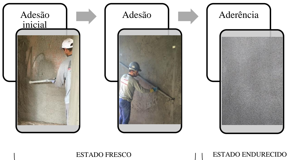
Figura 1 - Sequência de aderência da argamassa-substrato
