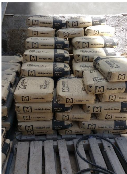
Figura 15 - Armazenamento da argamassa ensacada
