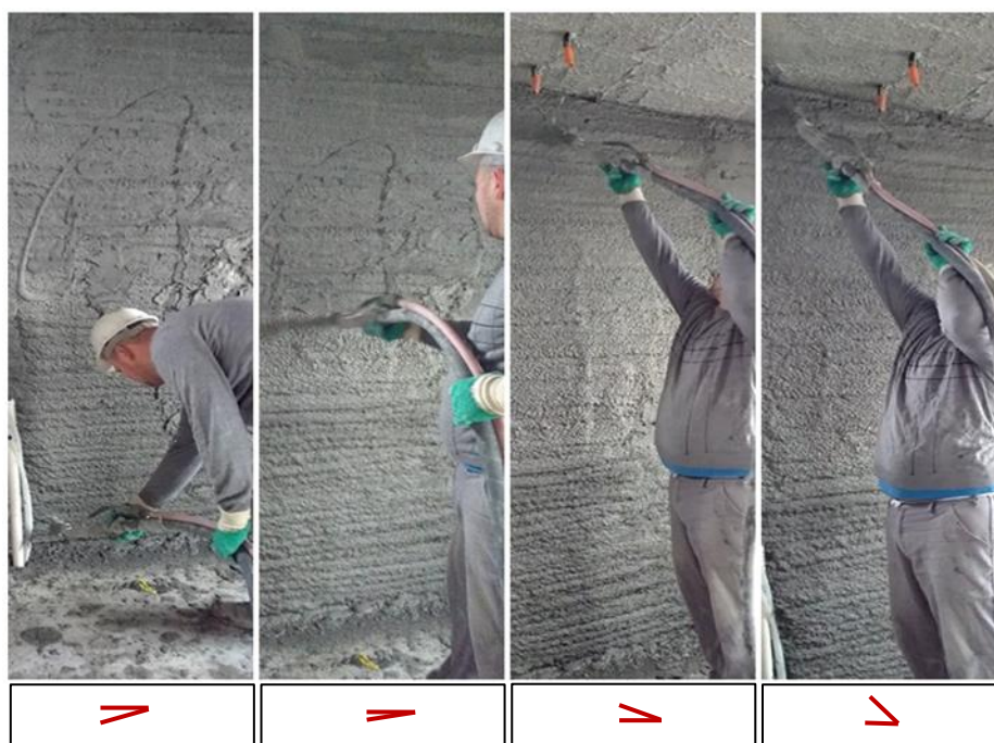
Figura 20 - Aplicação do revestimento, ressaltando-se as distintas inclinações da mangueira em relação ao plano da parede. Abaixo de cada posição do operador está representada a inclinação aproximada da mangueira com o plano horizontal.
