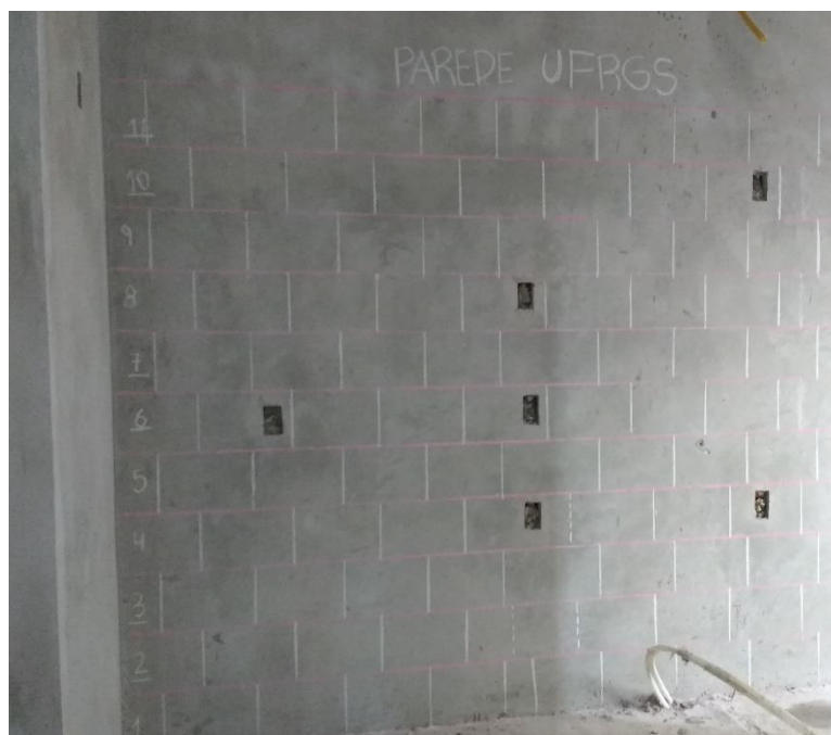
Figura 28 - Marcação das juntas de assentamento
