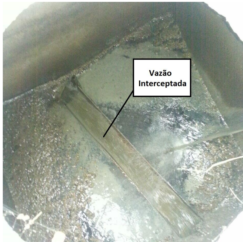
Figura 25 – Vista interna do Poço de Visita logo após a interceptação
