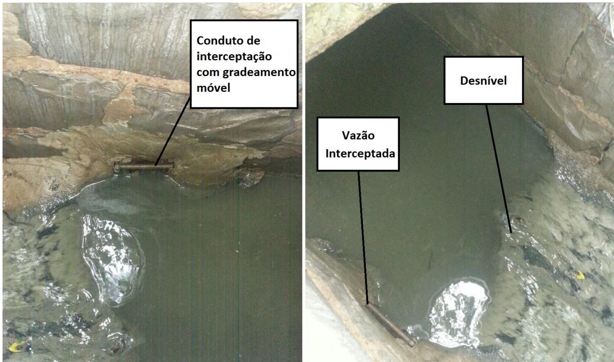
Figura 24 – Vista interna do Poço de Visita onde ocorre a interceptação
