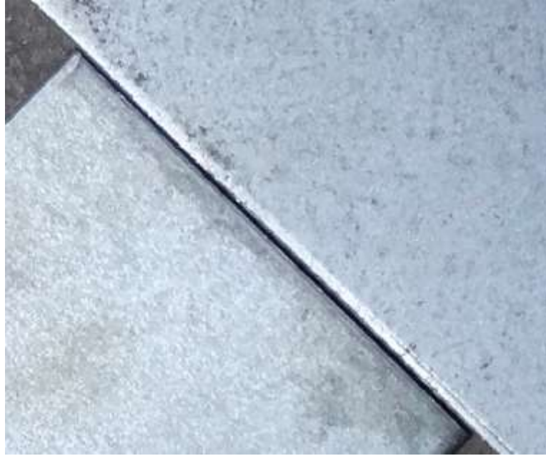
Figura 3.22 - Imagem ampliada de linha de solda em junta topo para apresentar as distâncias relativamente constantes.
