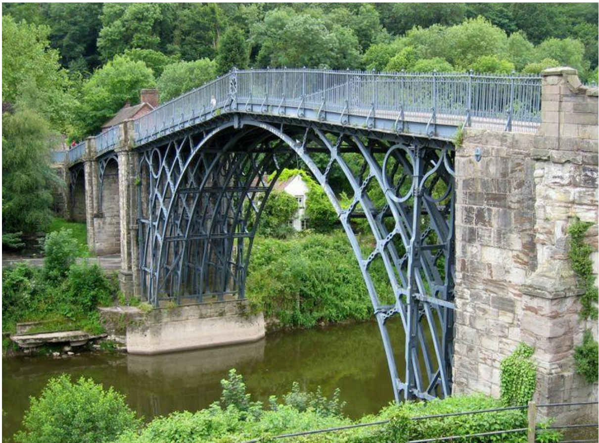
Figura 11 – Coalbrookdale Bridge sobre o rio Severn, Inglaterra.
