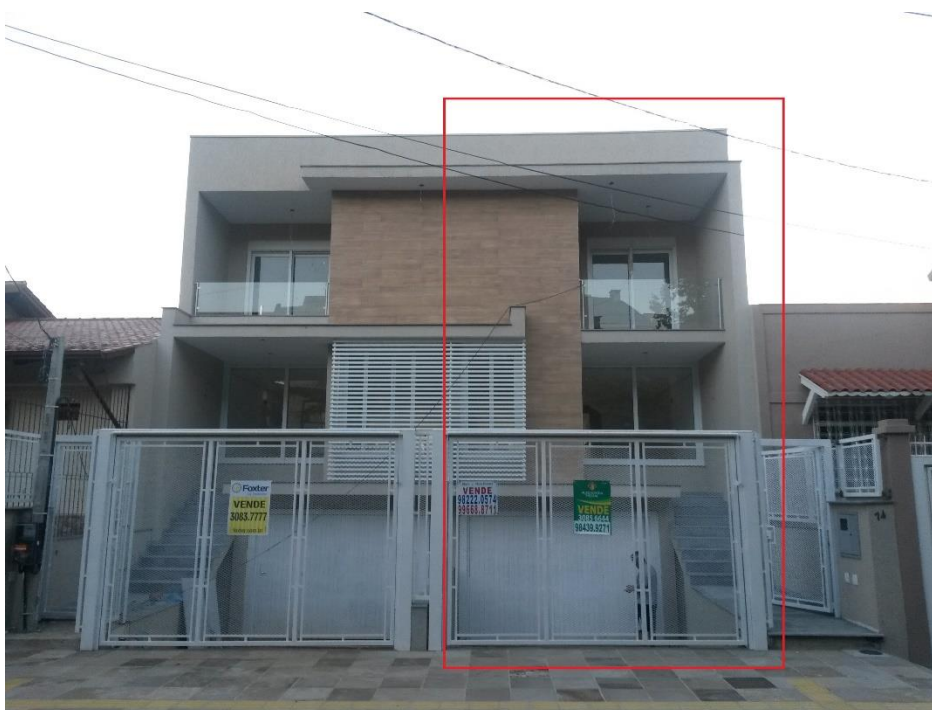
Figura 9 – Vista frontal da edificação
