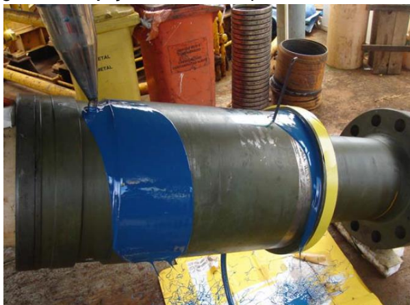
Figura 11: Injeção de resina epóxi dentro do end fitting
