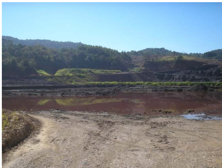
Figura 2. Drenagem Ácida de Minas gerada a partir da oxidação de sulfetos em bacias de rejeito de carvão dispostas a céu aberto
