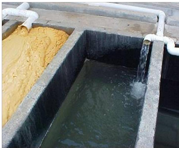
Figura 4. Estação DAM da carbonífera Metropolitana ( 5-10 \text{ m}^3 \cdot \text{h}^{-1} ). Processo NF-FAD ou Flotação por Ar Dissolvido
