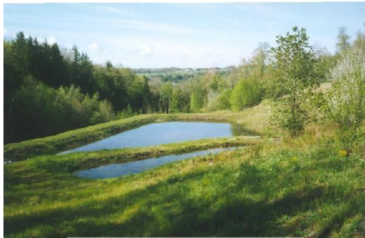
Figura 5. Vista de banhado anaeróbico de fluxo vertical. Fonte: Gusek (2003)
