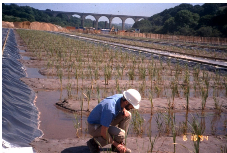
Figura 9. Vista de banhado aeróbico em fase de implantação. Fonte: Gusek (2003)
