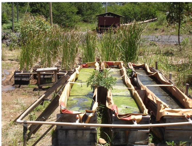
Figura 20. Vista geral do sistema aeróbico e misto no início do monitoramento.
