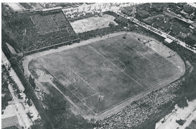
Eucaliptos no auge do funcionamento: arquibancadas de concreto e de madeira
