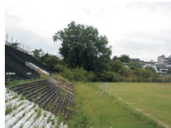
Arquibancada ao longo da Rua Barão do Guaíba
