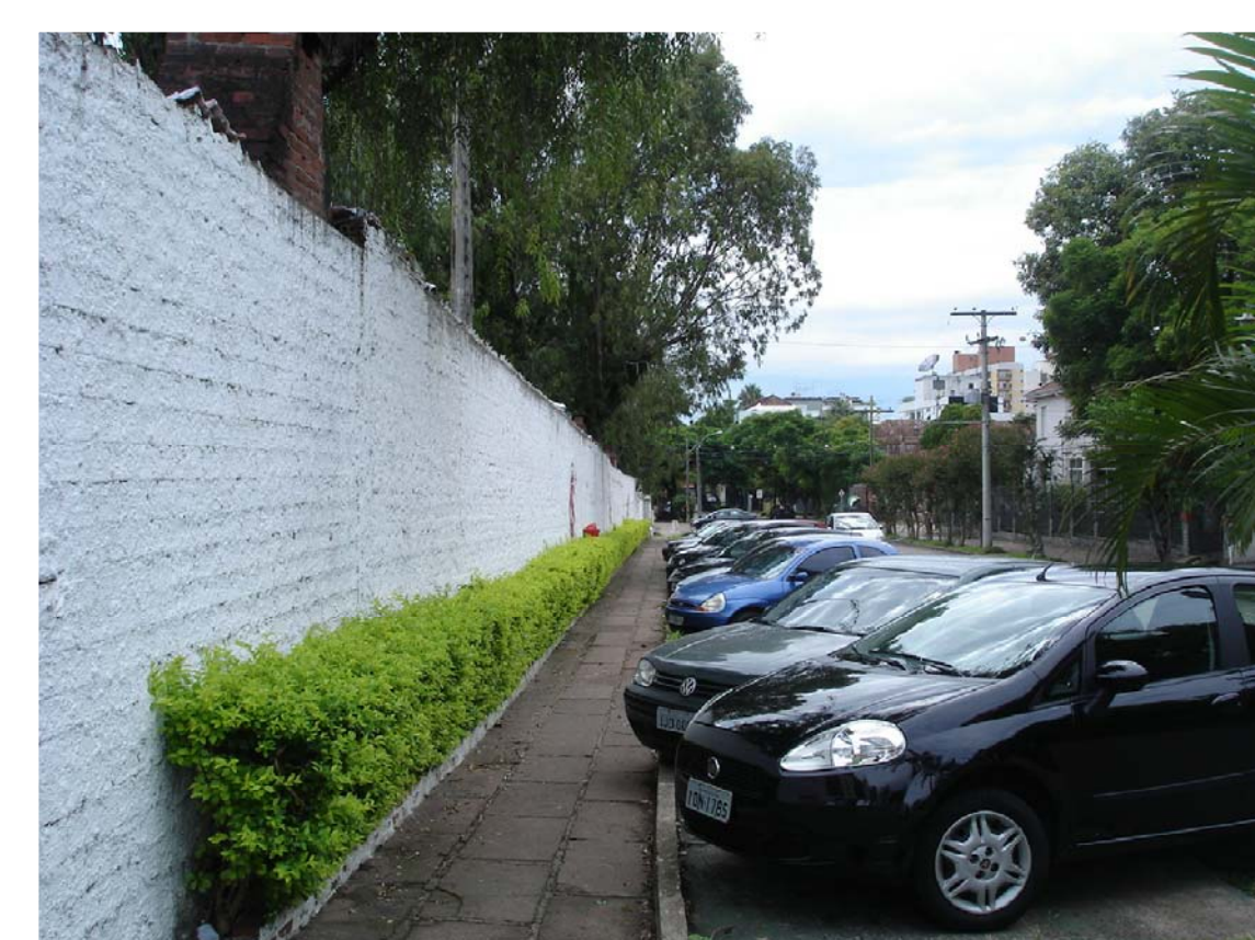
RUA DONA AUGUSTA - MURO NO ENTORNO DE TODO O QUARTEIRÃO
