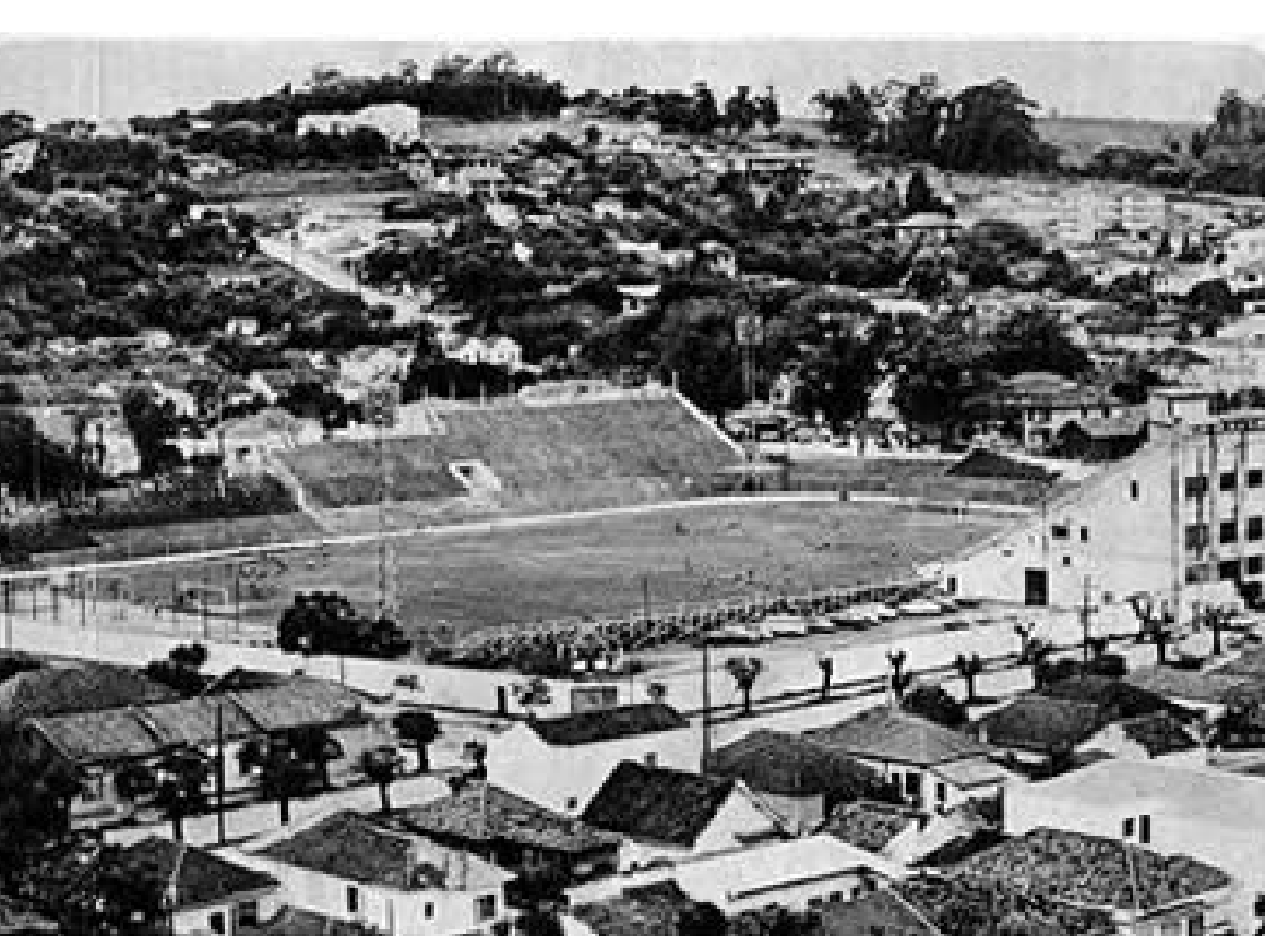
ESTÁDIO NO AUGE DO FUNCIONAMENTO - ANTES DE 1969
