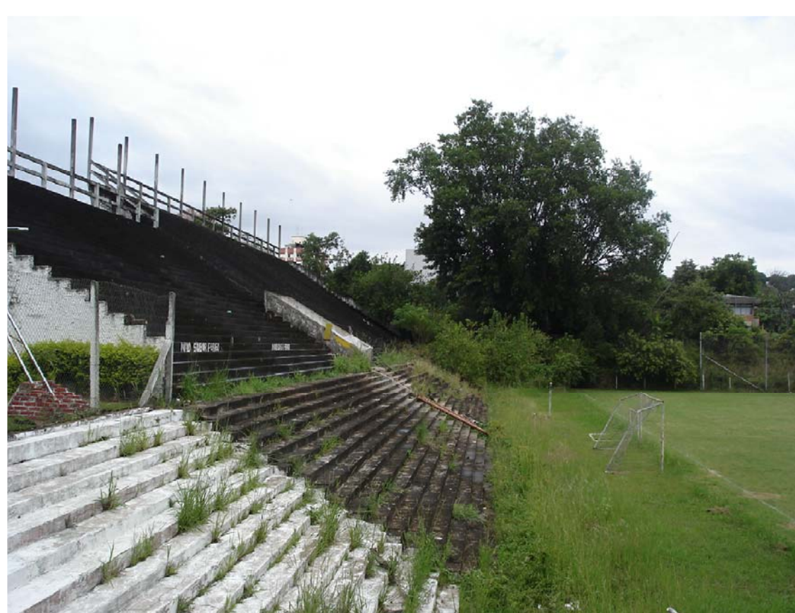
ARQUIBANCADAS EXISTENTES NO TERRENO JUNTO À RUA DONA AUGUSTA
