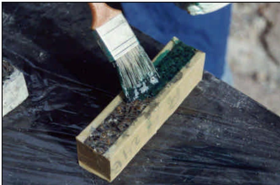
FIGURA 5.6 - Aplicação da primeira camada de adesivo epóxi
