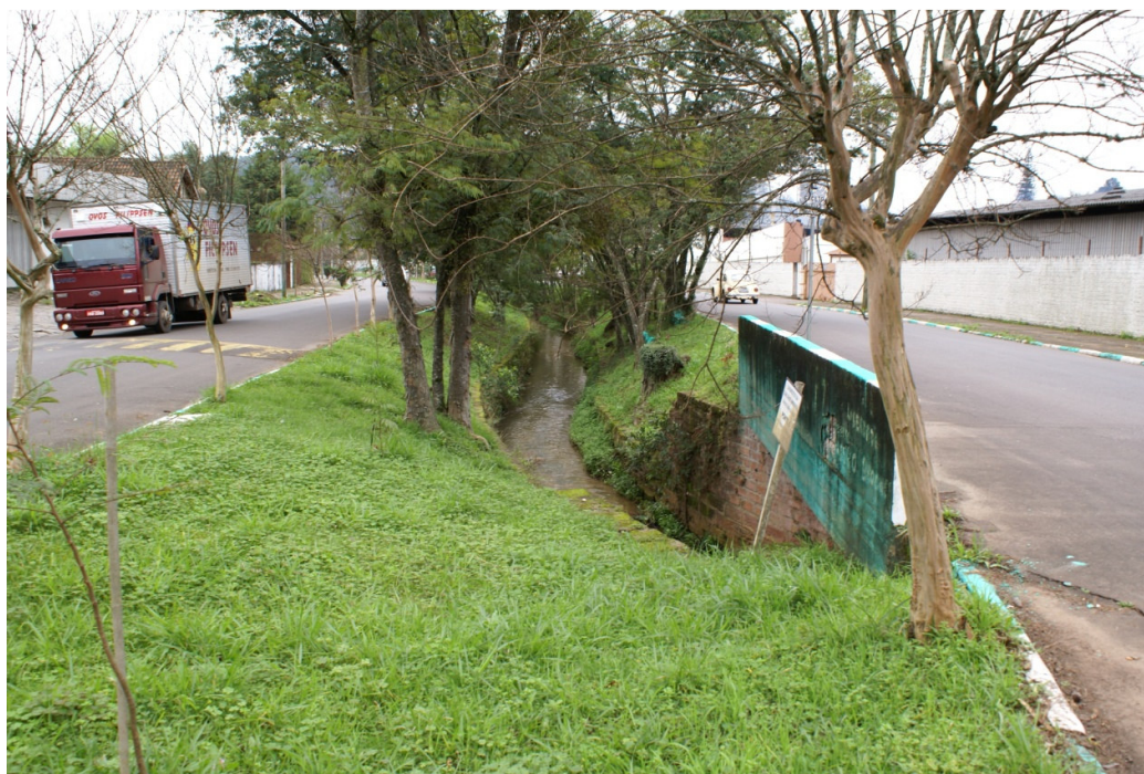
Figura 43 - Fotografia do local de coleta de água referente ao ponto 3: margens com barreiras de contenção. Fonte: Mezomo (2007).
