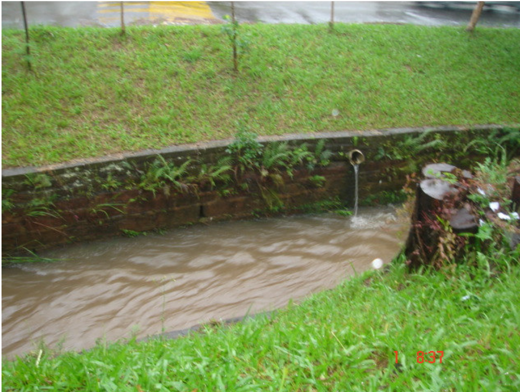
Figura 44 - Ponto 3: despejo do esgoto no arroio.
