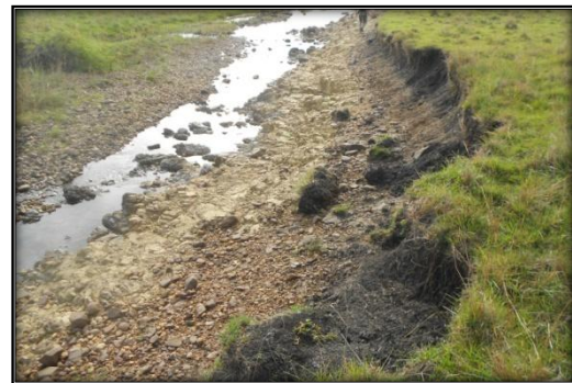
Fig.75. Arroio Pindaí-mirim, processo erosivo.
