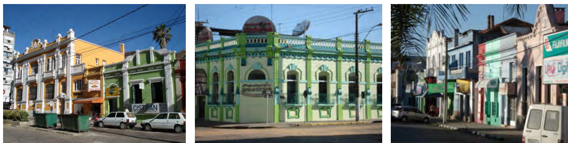
Figura 4.25: Destaque excessivo das edificações no contexto da rua através do uso das cores saturadas Bagé. Brasil, 2007. Fonte: fotografias da autora.
