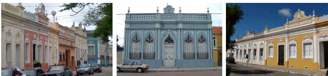
Figura 4.19: Exemplos da coloração das edificações históricas da cidade de Jaguarão, Brasil, 2006-2007. Fonte: fotografias da autora.
