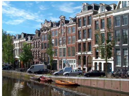
Figura 3.20: Edificações antigas da cidade de Amsterdã. Holanda, 2006. Fonte: foto da autora.
