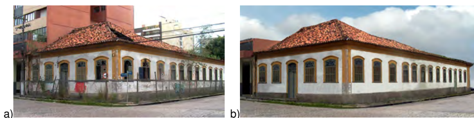
Figura 4.35: Exemplo de reconstrução gráfica da aparência da edificação na Rua Felix da Cunha, nº703. Pelotas, Brasil. Notas: a) Fotografia original de 2007; e b) o estado da imagem depois do retoque gráfico realizado.
