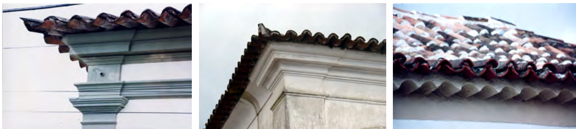
Figura 4.30: Finalizações dos telhados das edificações coloniais, cidade de Piratini, Brasil, 2000-2007.
