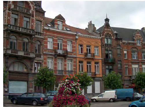
Figura 3.11: Edificações residenciais da cidade de Gent. Bélgica, 2007. Fonte: fotografia da autora
