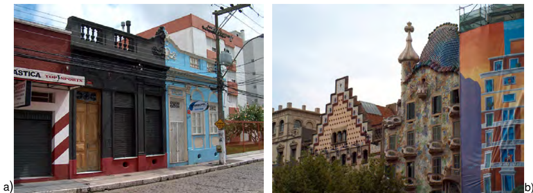
Figura 3.12: Exemplos das edificações com pintura chamativa que provoca aumento de atratividade.
