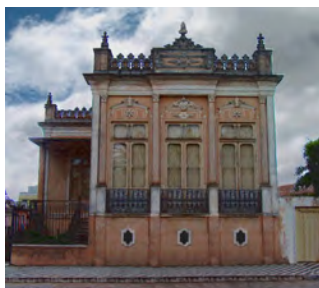
Figura 4.32: Edificação em Jaguarão, 2007. Brasil.
