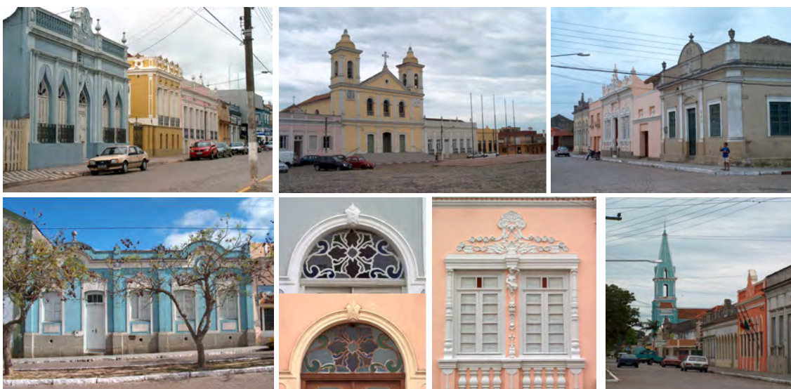
Figura 4.18: Imagens das edificações da cidade de Jaguarão, Brasil, 2006-2007. Fonte: fotografias da autora.
