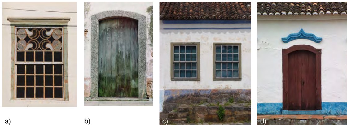
Figura 4.29: Detalhes das esquadrias das edificações coloniais das cidades de Piratini, São José do Norte e Santo Amaro, Brasil, 2000-2006. Fonte: Fotografia da autora e de Ana Paula Neto de Faria.
