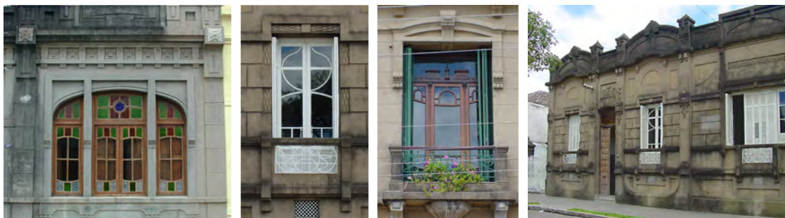
Figura 4.36: Exemplos dos elementos decorativos e estruturais das edificações pré-modernistas em Pelotas e Bagé, Brasil. 2002-2007. Fonte: fotografias de autora (a) e de Carina Hamm (b) e (c).
