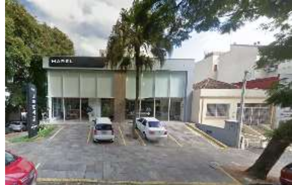
(4) Edificação do tipo “construído para alugar” na cidade de Porto Alegre.
