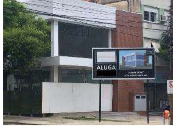
(2) Edificação do tipo “construído para alugar” na cidade de Porto Alegre..
