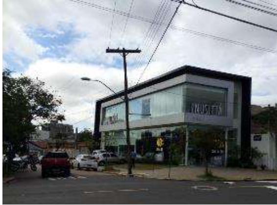
(1) Edificação do tipo “construído para alugar” na cidade de Porto Alegre.
