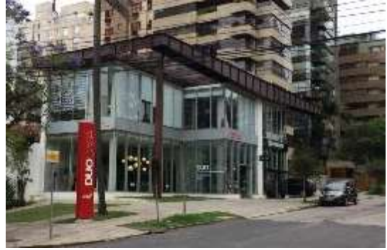
(2) Edificação do tipo “Construído para alugar” com a atividade de loja de revestimentos para construção, em Porto Alegre
