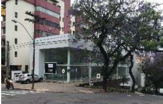
(3) Edificação do tipo “construído para alugar” na cidade de Porto Alegre.
