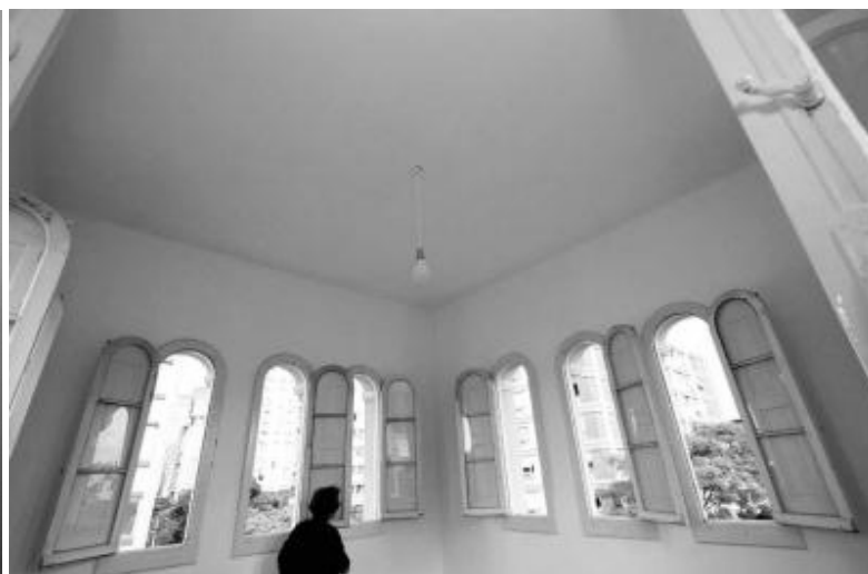
Figura 66. Torreão, janelas da torre.
