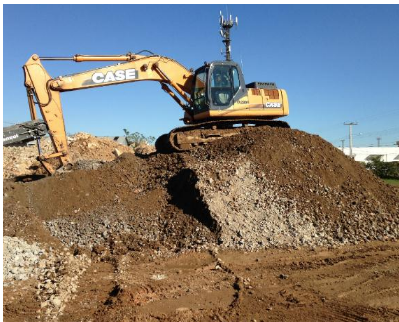
Figura 14 – armazenamento, em pilhas, do RCD cinza britado
