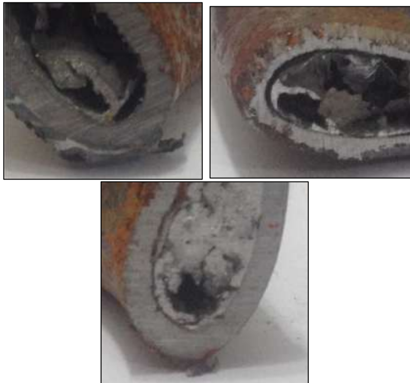
Figura 4.27 Descolamento interface espuma de alumínio/tubo de aço.
