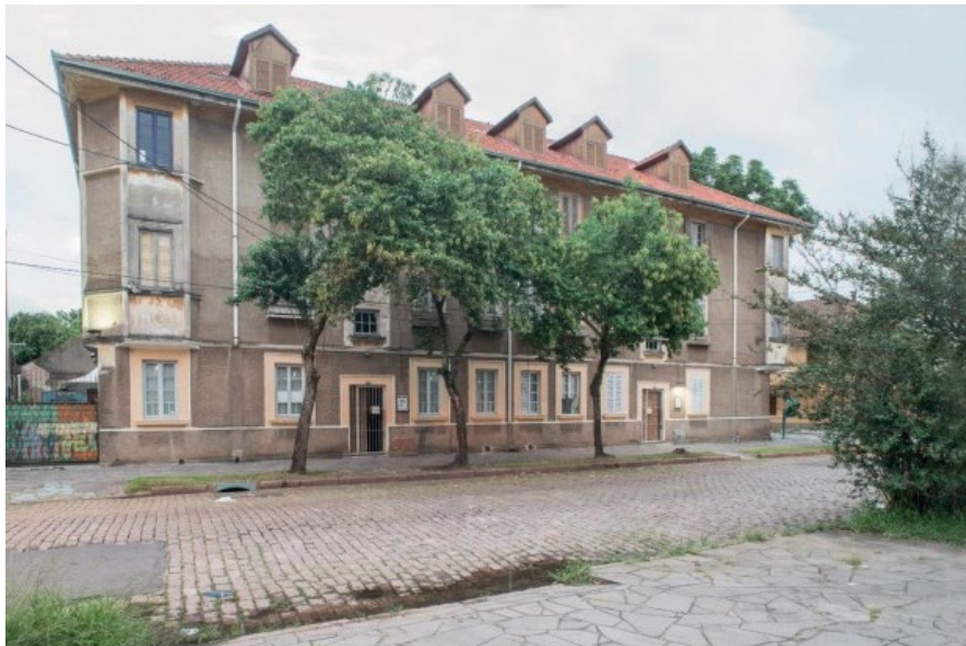
Figura 4. Uma das fachadas da edificação – Associação Vila Flores
