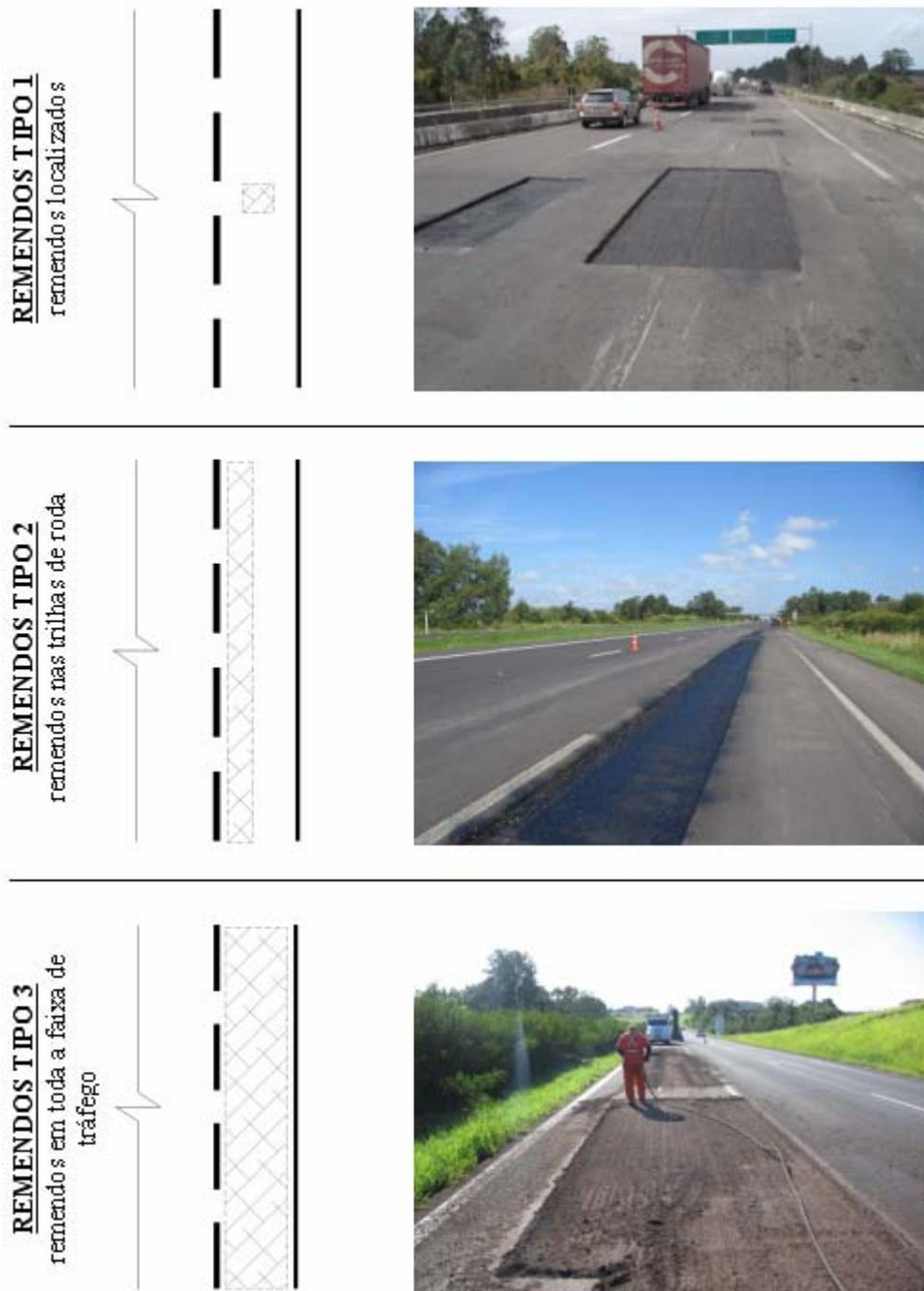
Figura 24: Representação esquemática dos 3 tipos de remendos profundos usualmente executados na rodovia BR-290/RS.
