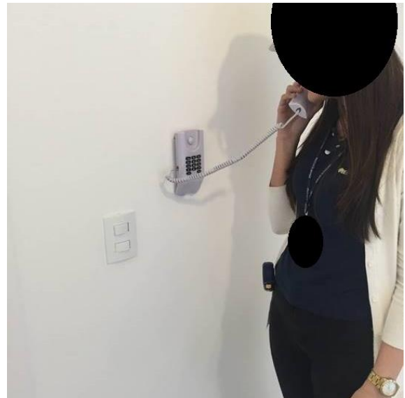
Figura 34 – Teste do interfone
