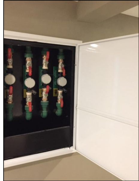
Figura 10 – Caixa dos hidrômetros dos apartamentos com fundo todo preto e identificado
