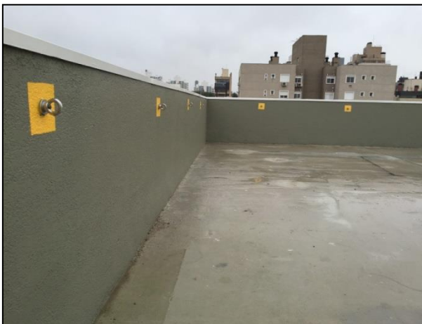
Figura 11 – Platibanda com pintura padrão e ganchos padronizados
