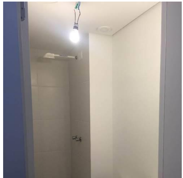
Figura 32 – Teste do chuveiro, caimento do box e elétrico
