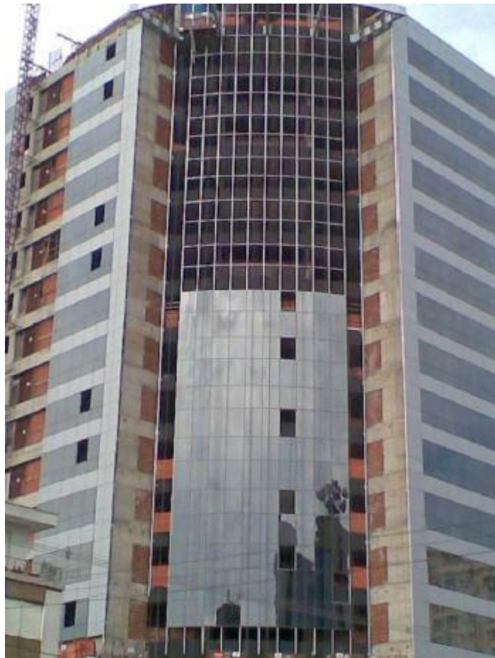
Figura 3 – Fachada pele de vidro
