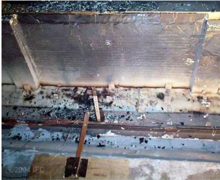
Figura 42 – Superfície não exposta da barreira periférica contra fogo após o término do ensaio
