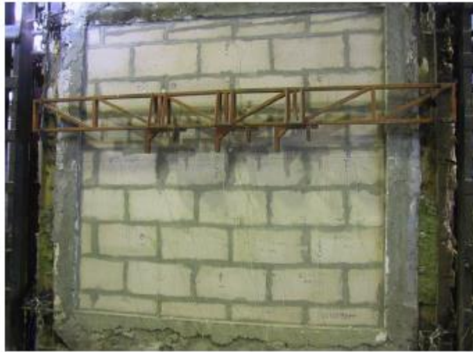
Figura 27 – Parede de compartimentação corta-fogo
