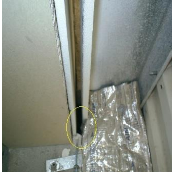
Figura 21 – Fresta aberta após a conclusão da barreira periférica contra fogo
