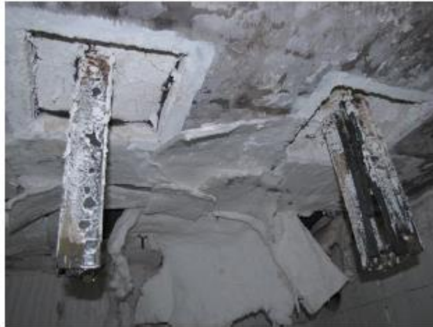
Figura 25 – Selagem corta-fogo em entrepiso de compartimentação
