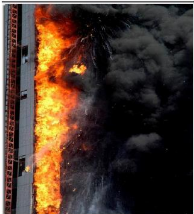
Figura 1 – Incêndio em fachada pele de vidro
