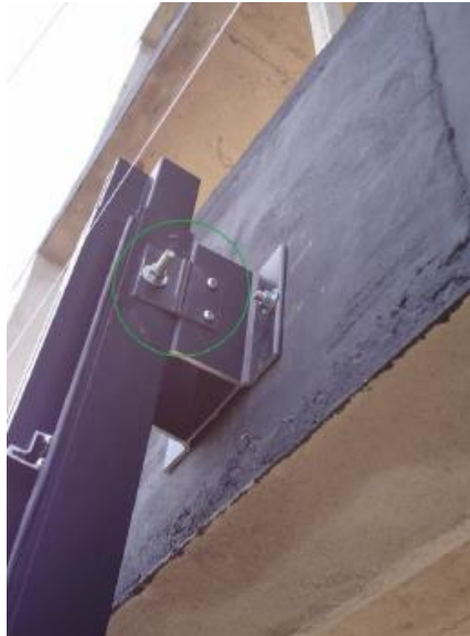
Figura 9 – Ancoragem do montante à supraestrutura do edifício
