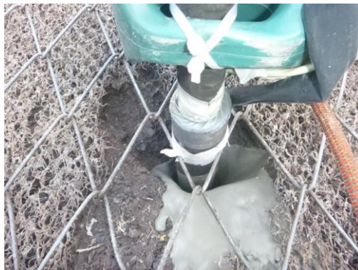
Figura 42. Injeção de calda na barra 2.
