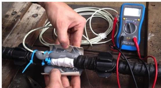
Figura 36. Aplicação da camada final de proteção.
