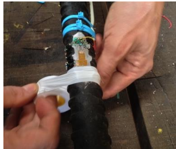
Figura 34. Aplicação de fita teflon para proteção dos circuitos.
