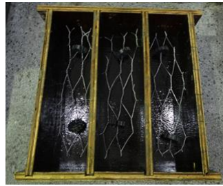
Figura 15 – Fôrma com armadura posicionada e espaçadores
