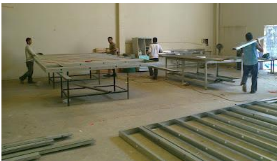
Figura 9 - Montagem prévia dos painéis em LSF
