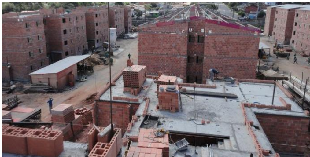
Figura 23 - Canteiro de obra de prédios em alvenaria estrutural
