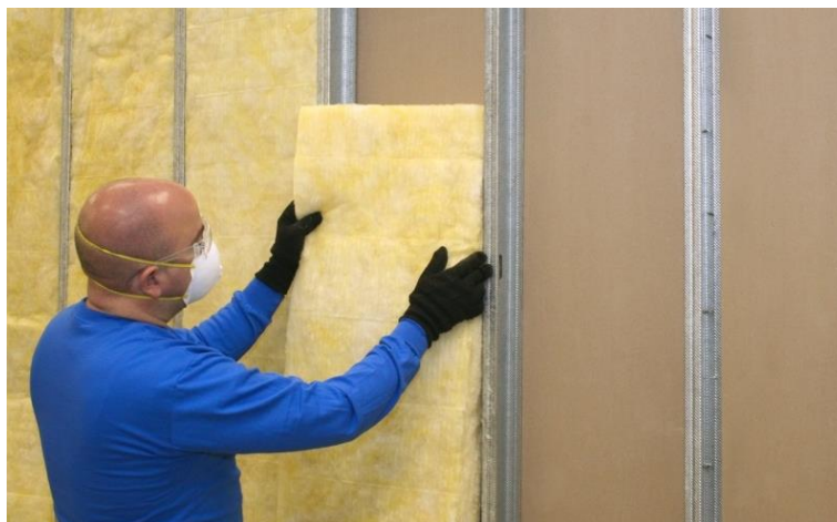
Figura 13 - Aplicação de manta de lã de vidro no interior dos painéis
