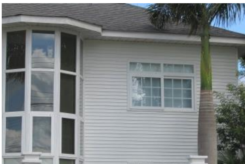
Figura 19 - Edificação em LSF revestido com Siding Vinílico
