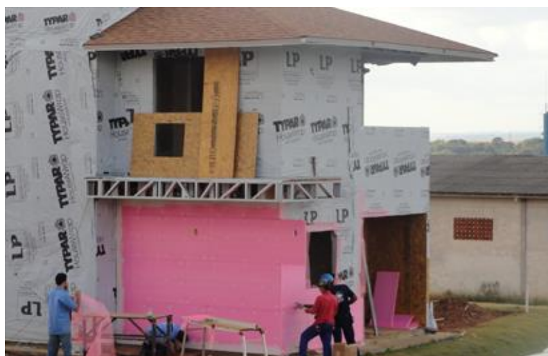
Figura 14 - Aplicação de placas XPS no exterior dos painéis
