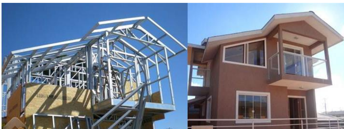
Figura 4 - Casa construída no sistema LSF
