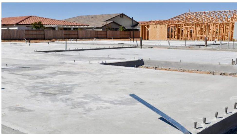
Figura 6 - Fundação tipo radier
