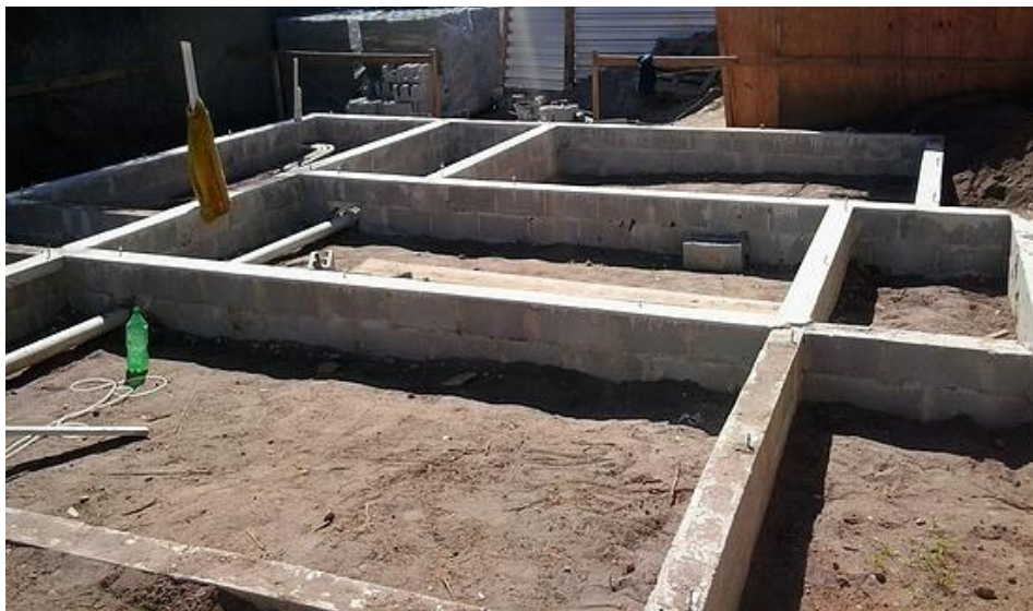
Figura 7 - Fundação tipo sapata corrida
