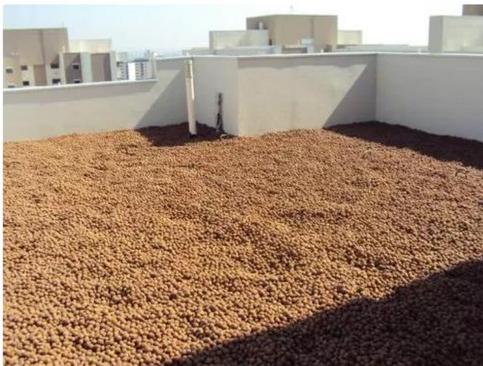
Figura 36 – Argila expandida aplicada em laje
