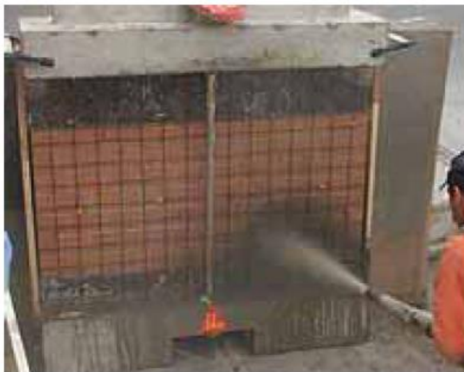
Figura 20 – Projeção de concreto
