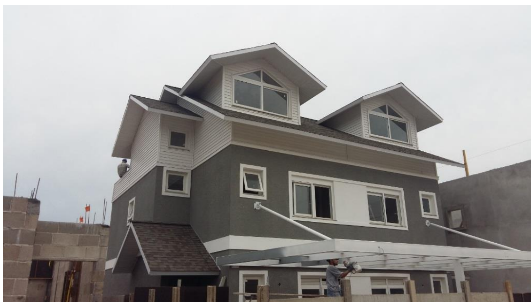
Figura 28 – Unidade com acabamentos finais no encontro do sótão com a estrutura convencional.
