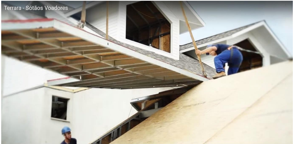
Figura 22 – Montagem da estrutura de cobertura do sótão pré-fabricado
