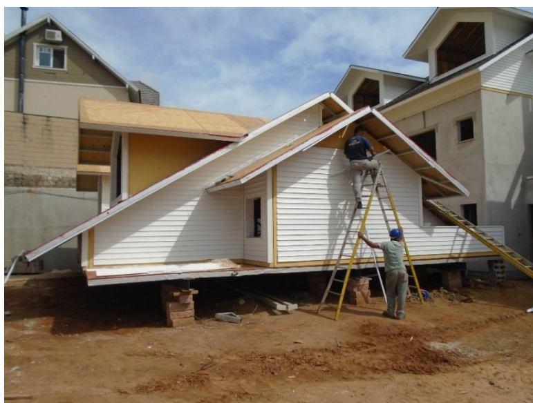
Figura 34 – Operários instalando Siding Vinílico
