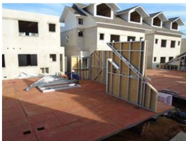
Figura 17 – Paredes do sótão sendo montadas sobre a cama de montagem
