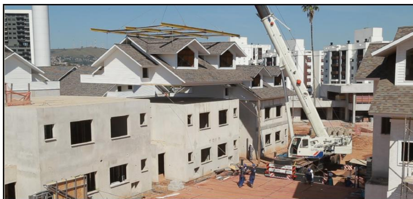
Figura 9 – Posicionamento do sótão pré-fabricado no local de destinação
