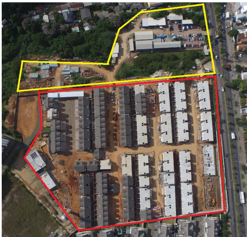
Figura 30 – Figura aérea que mostra a demarcação do canteiro de obras e a área de apoio
