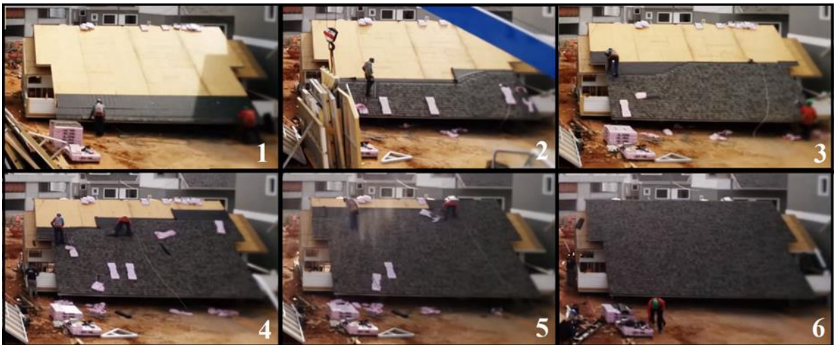
Figura 23 – Instalação dos componentes de cobertura do sótão pré-fabricado
