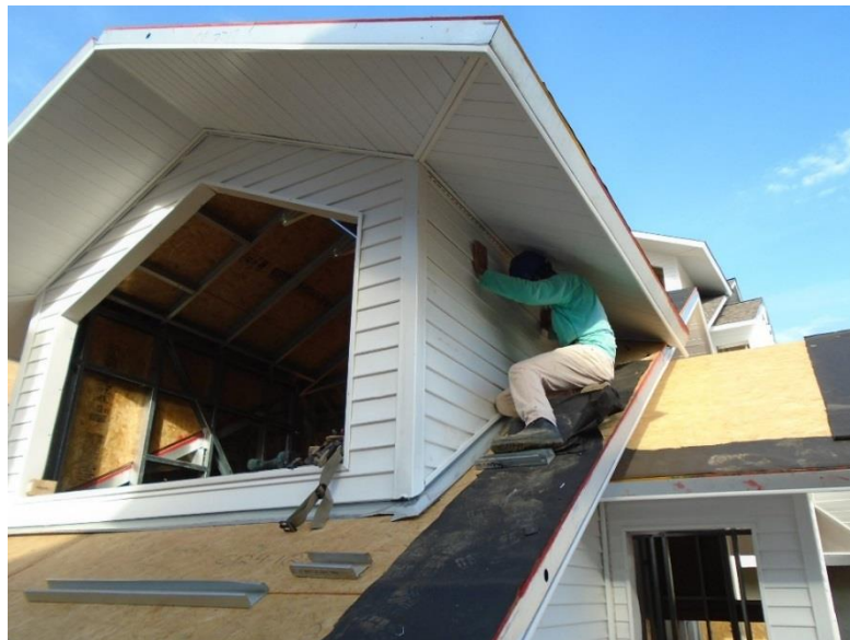
Figura 24 – Instalação de forro de PVC e limpeza final do revestimento externo
