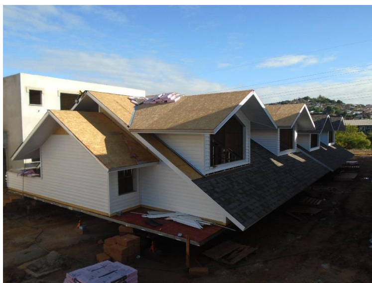
Figura 26 – Sótão com vedação lateral
