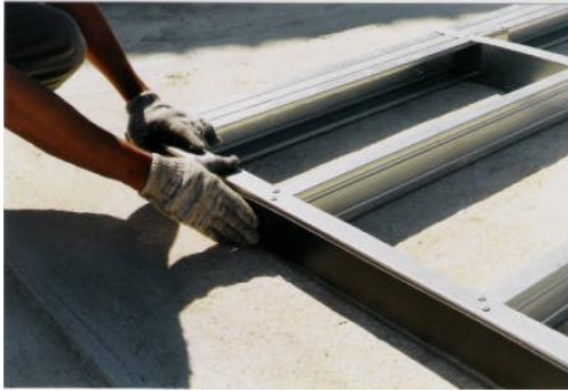
Figura 19 – Aplicação de fita isolante de neoprene na base dos painéis de parede
