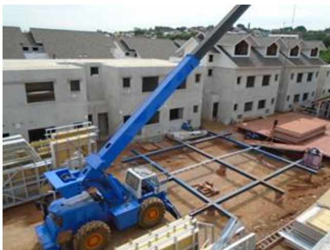
Figura 16 – Cama de montagem sendo montada
