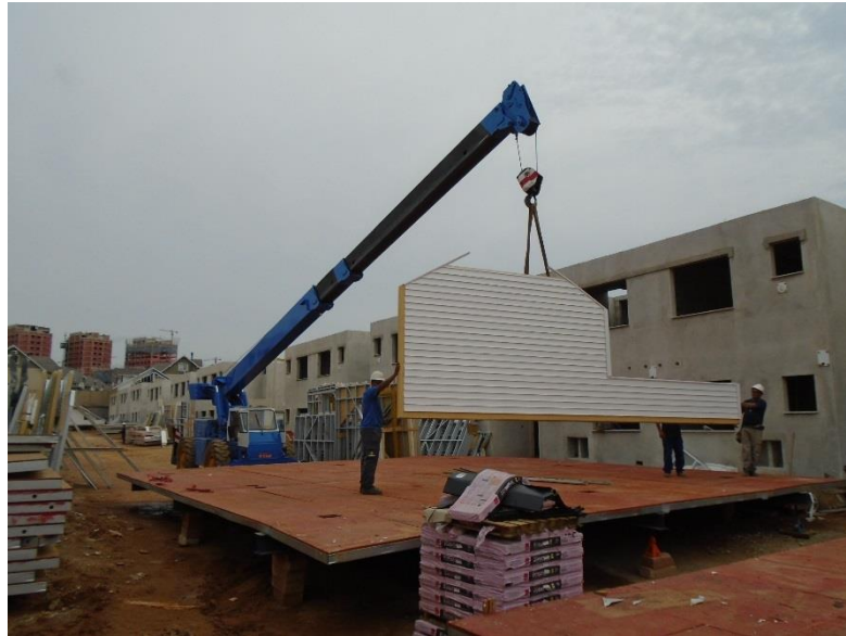
Figura 18 – Paredes do sótão sendo montadas sobre a cama de montagem
