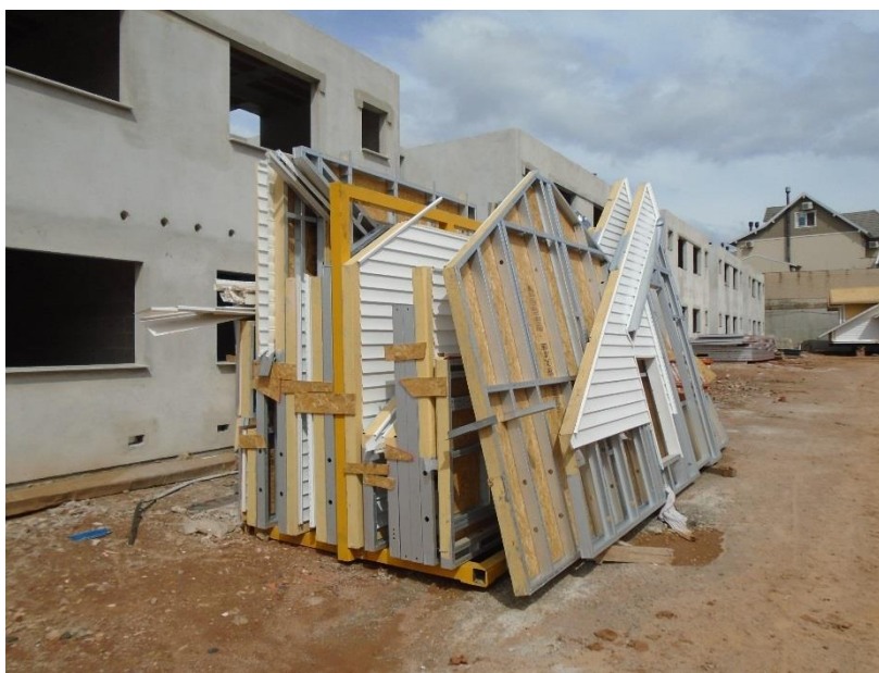
Figura 15 – Palete estocado no canteiro contendo painéis pré-fabricados
