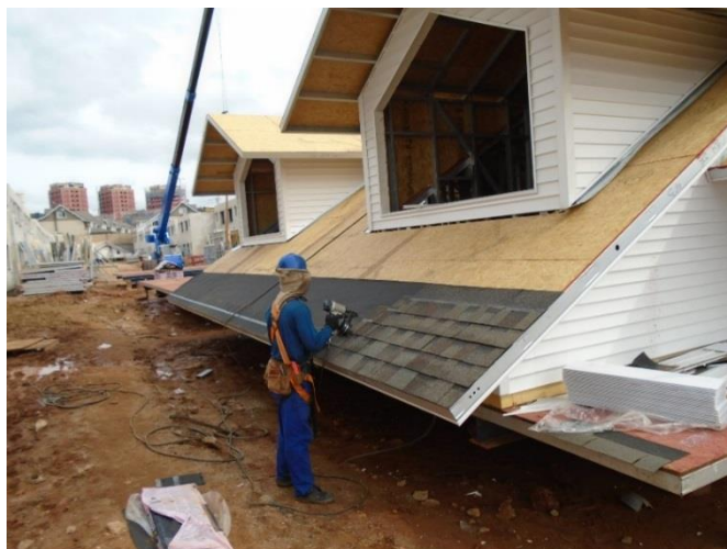
Figura 33 – Instalação de telhas Shingle no nível do solo
