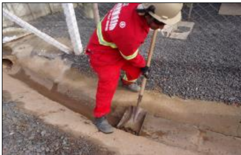
Figura 9 – Limpeza de canaletas
