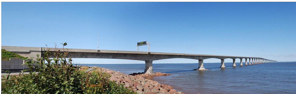
Figura 4 – Trecho da Confederation Bridge cruzando o estreito de Northumberland.
