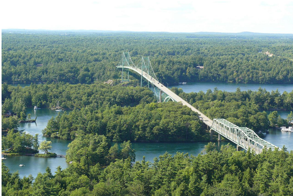
Figura 3 – Vista do lado canadense da Thousand Islands Bridge apresentando três sistemas estruturais: suspensão, arco e treliça.
