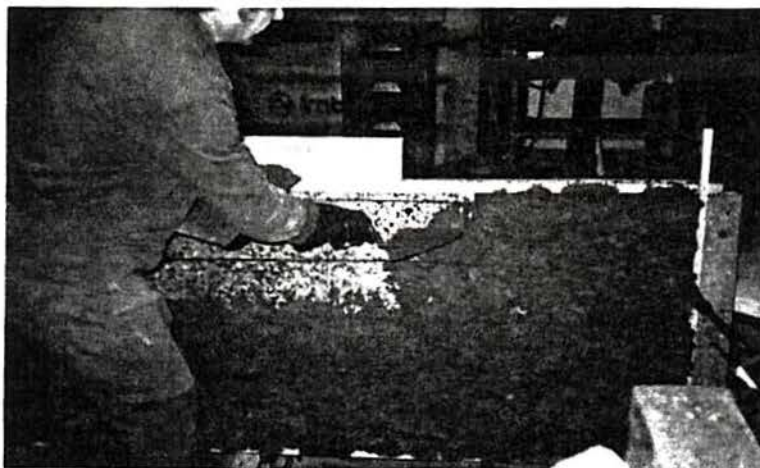
Figura 4.15 Aplicação da argamassa sobre a laje.
