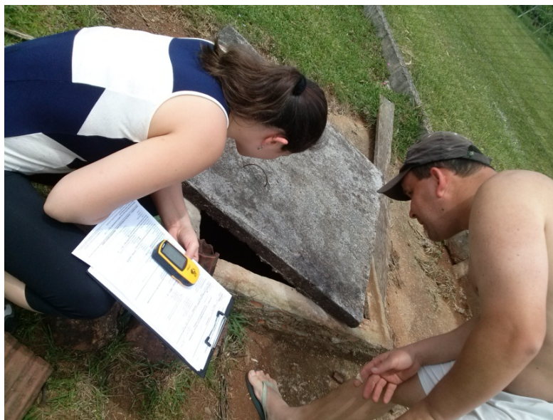
Figura 32: Poço raso tamponado.
