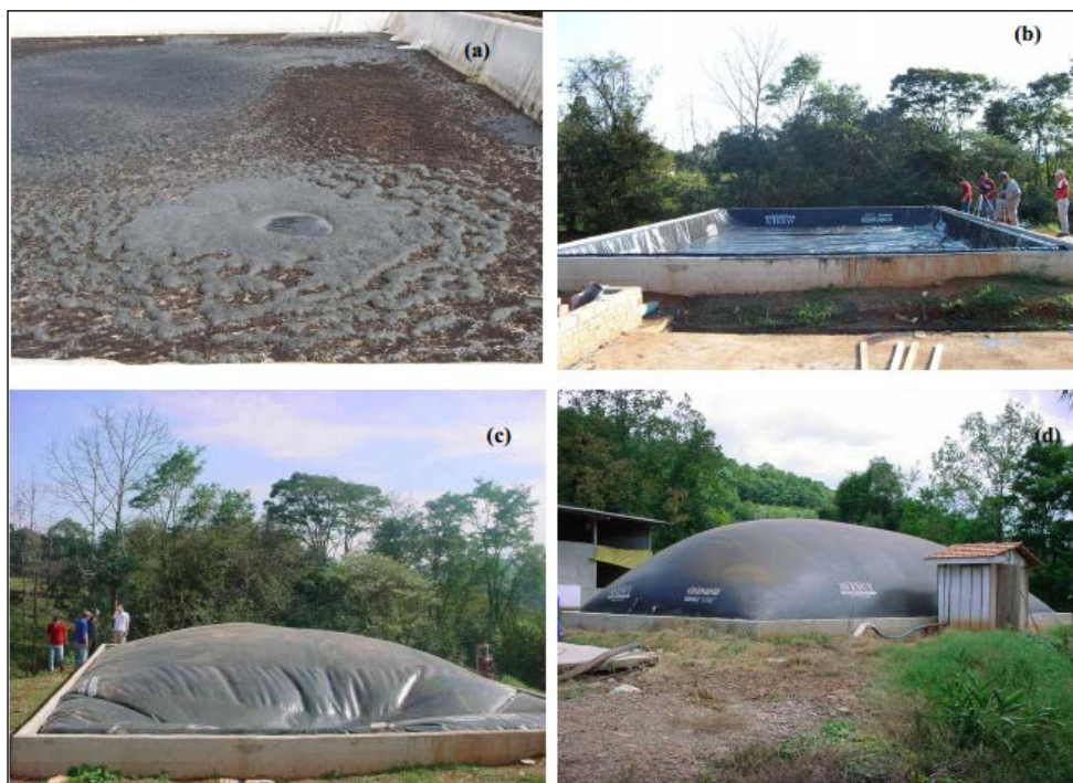
Figura 21: Construção de um modelo canadense de biodigestor. Fonte: EMBRAPA, 2010
