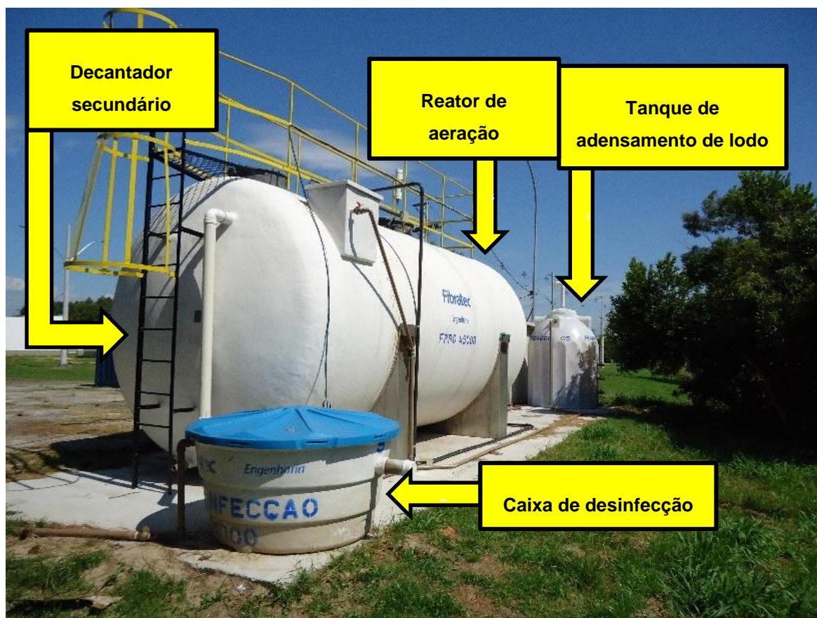
Figura 4.2: Fotografia da ETE do Campus Litoral Norte da UFRGS mostrando algumas etapas do tratamento.
