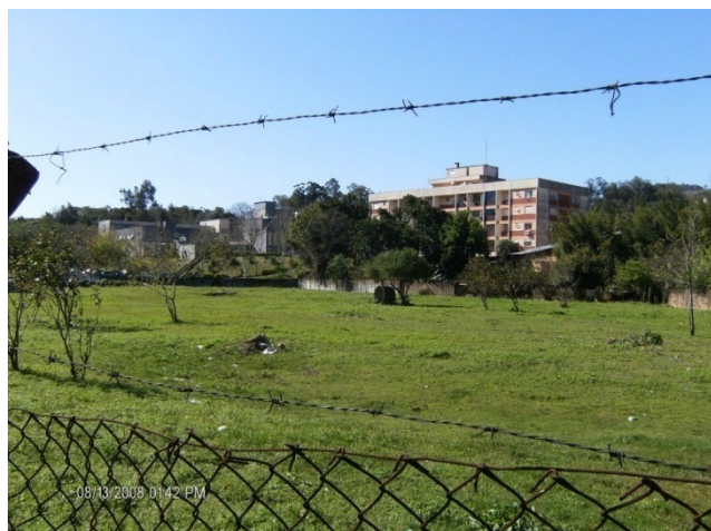
9 – vista para o terreno de projeto
