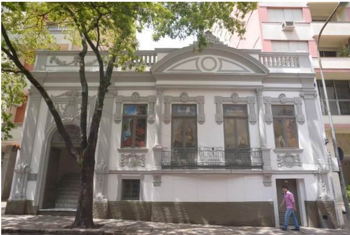
Imagem 3 – Fachada da Pinacoteca Ruben Berta
