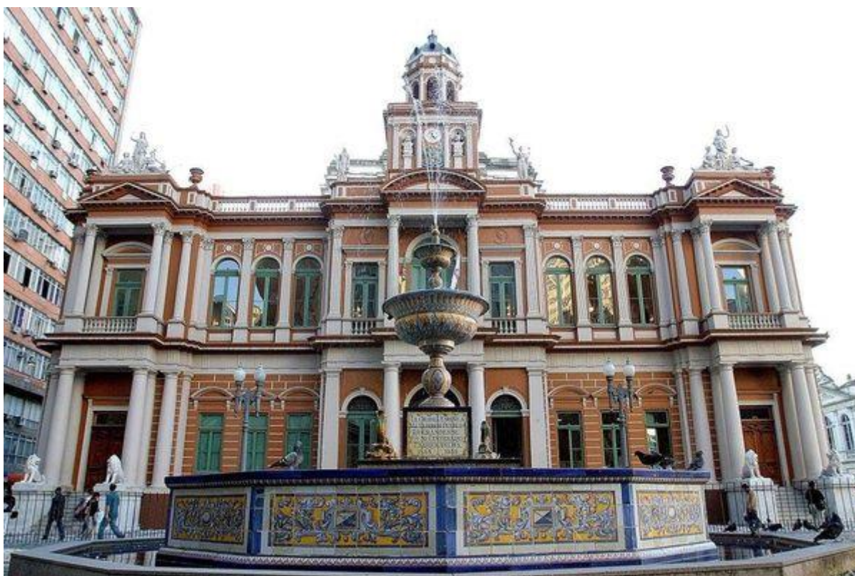
Imagem 2 – Fachada do prédio da Prefeitura de Porto Alegre, sede da Pinacoteca Aldo Locatelli
