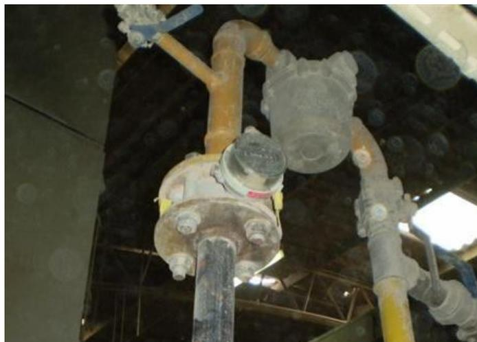
Figura 6.1: Medidor de vazão instalado na planta.
