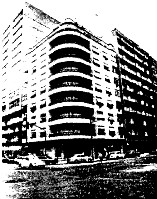
Ilustração 96 - Edifício Rio Verde, Rio de Janeiro, década de 30/40.
