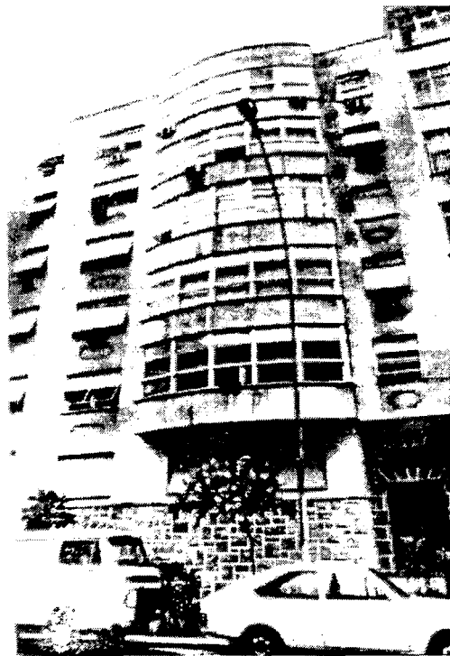
Ilustração 95 - Edifício Joaquim Nabuco, Rio de Janeiro, década de 30-40.
