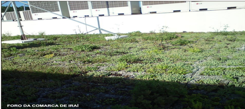
Figura 32:Telhado verde na Comarca de Iraí
