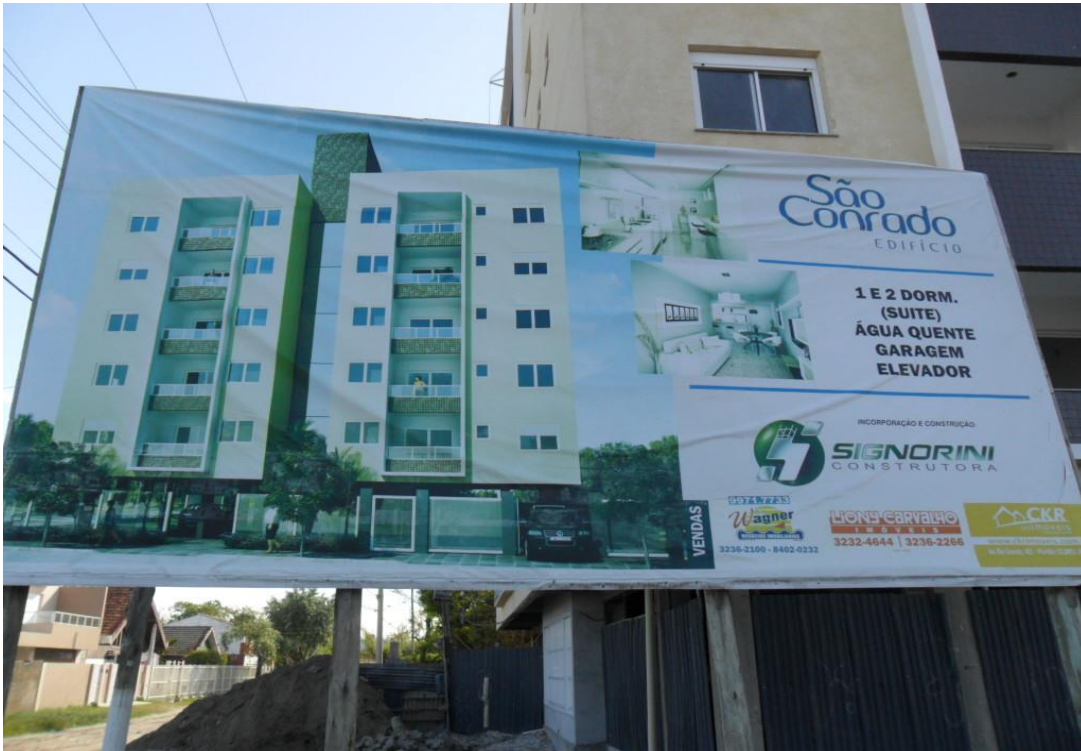
Figura 20: Prédio em construção na Rua Montevideú, próximo à Av. Rio Grande. Foto: A autora
