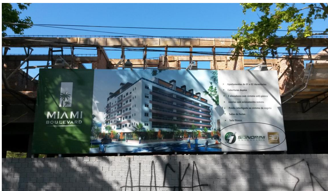
Figura 30: Prédio em construção na Av. Rio Grande, nº 374.
