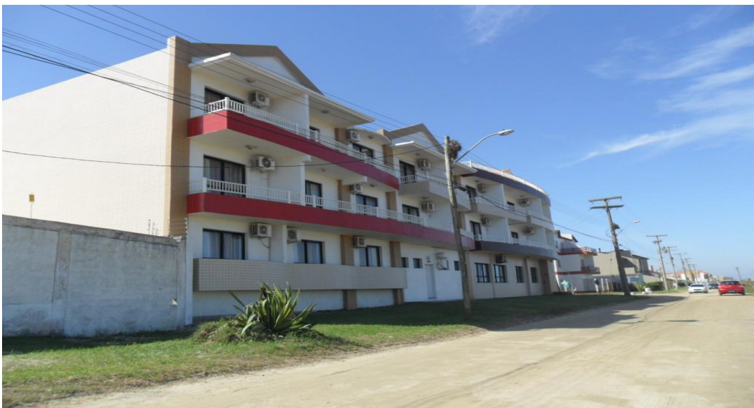
Figura 29: Prédio na Av. Beira Mar. Foto: A autora
