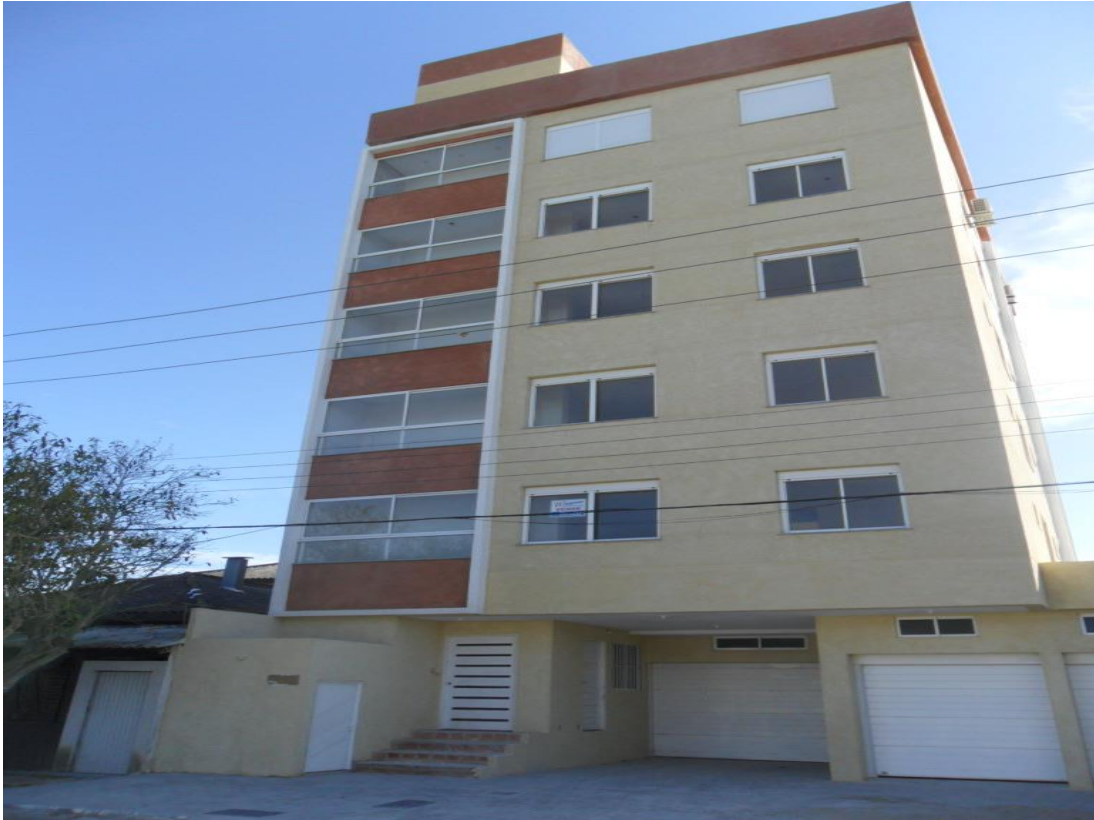
Figura 22: Prédio em construção na Av. Rio de Janeiro. Foto: A autora
