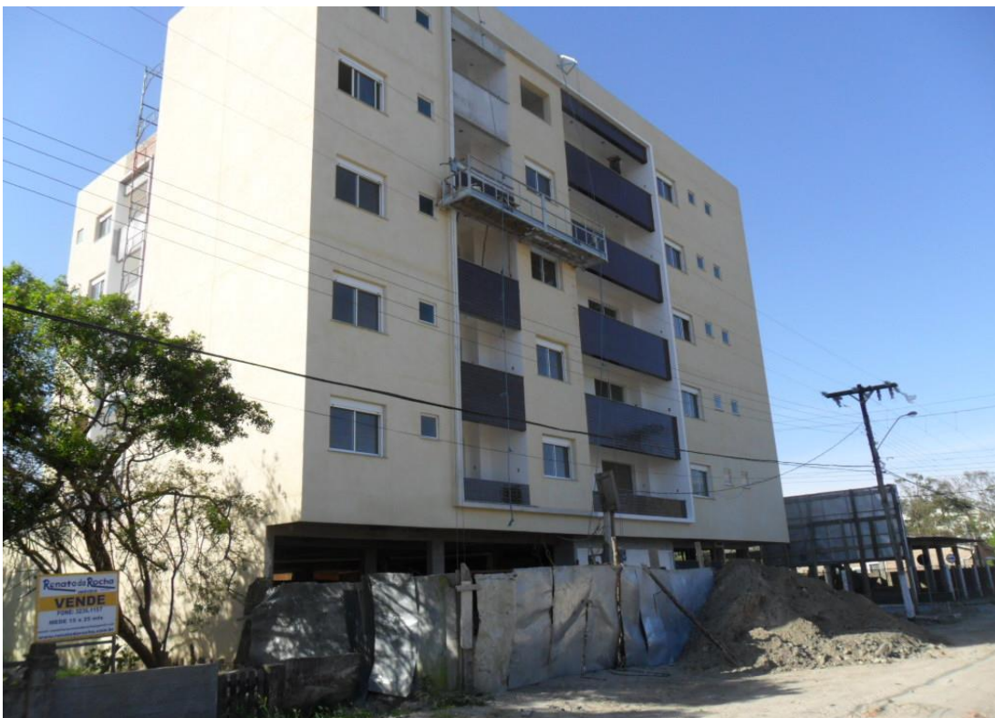
Figura 21: Prédio em construção na Rua Montevideú, próximo à Av. Rio Grande. Foto: A autora
