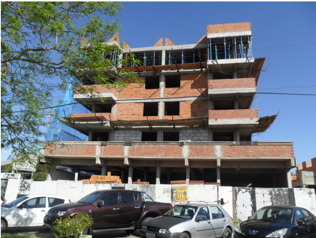
Figura 19: Prédio em construção na Av. Osvaldo Cruz, próximo à Av. Rio Grande. Foto: A autora
