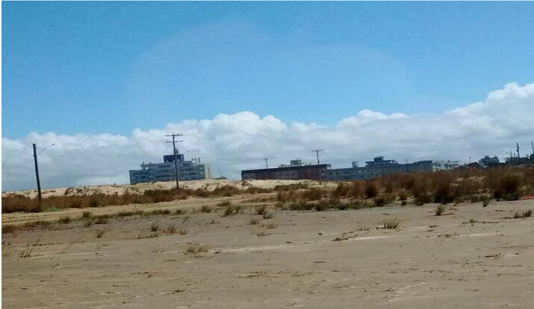
Figura 24: Vista da beira da praia dos prédios mais próximos da Av. Beira Mar. Foto: A autora
