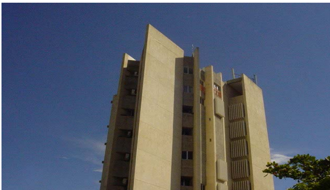
Foto 12: Edifício Sede do GPZ na cidade de Tete – Região do Vale do Zambeze Fonte: Do Autor, 2006
