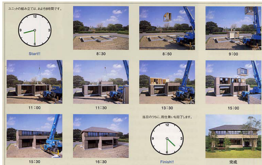
Figura 15: Processo de instalação das casas Misawa (RICHARD; NOGUCHI, 2006)
