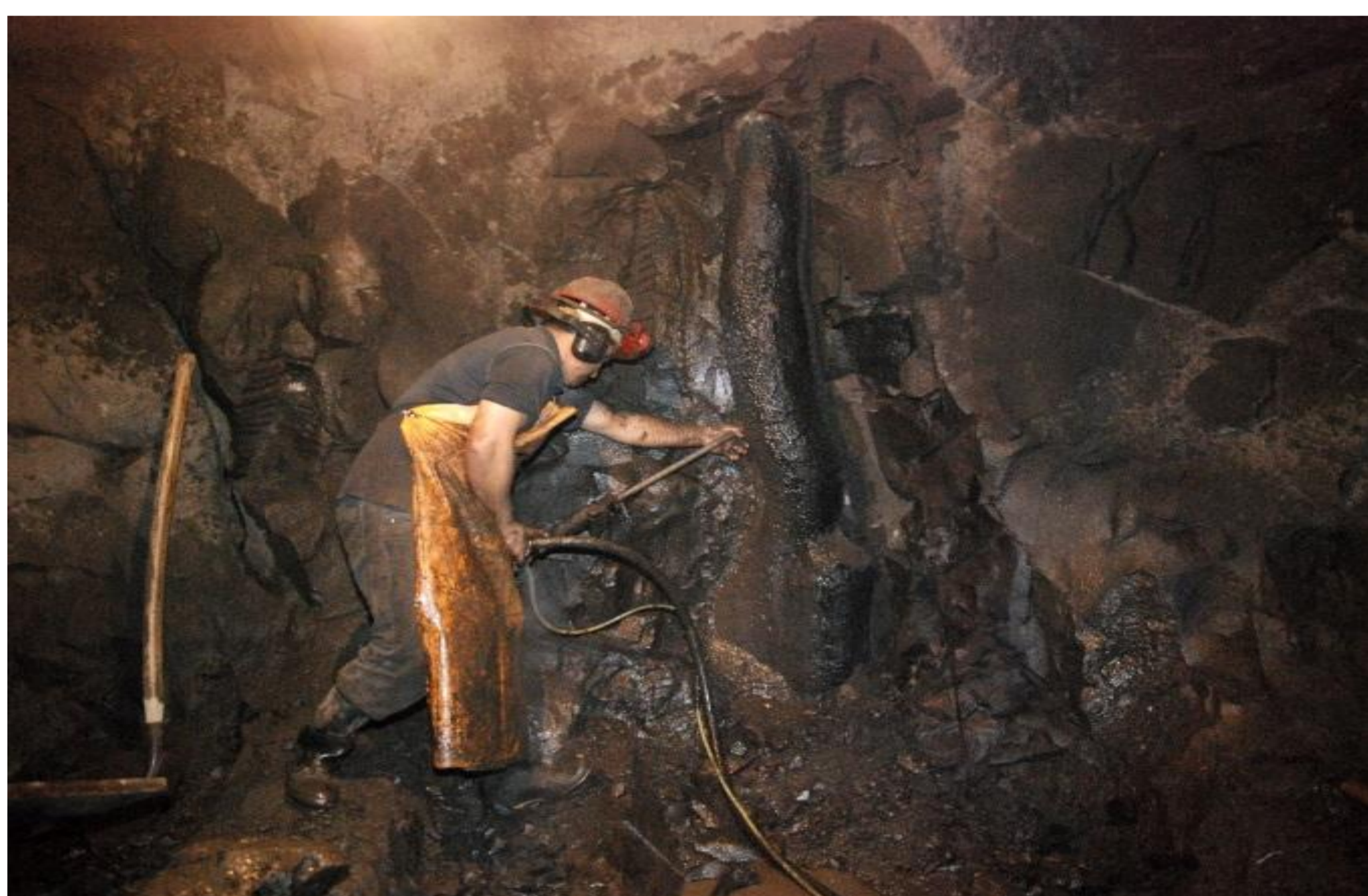
Figura 1. Perfuração da rocha a úmido associada ao uso de EPIs.
