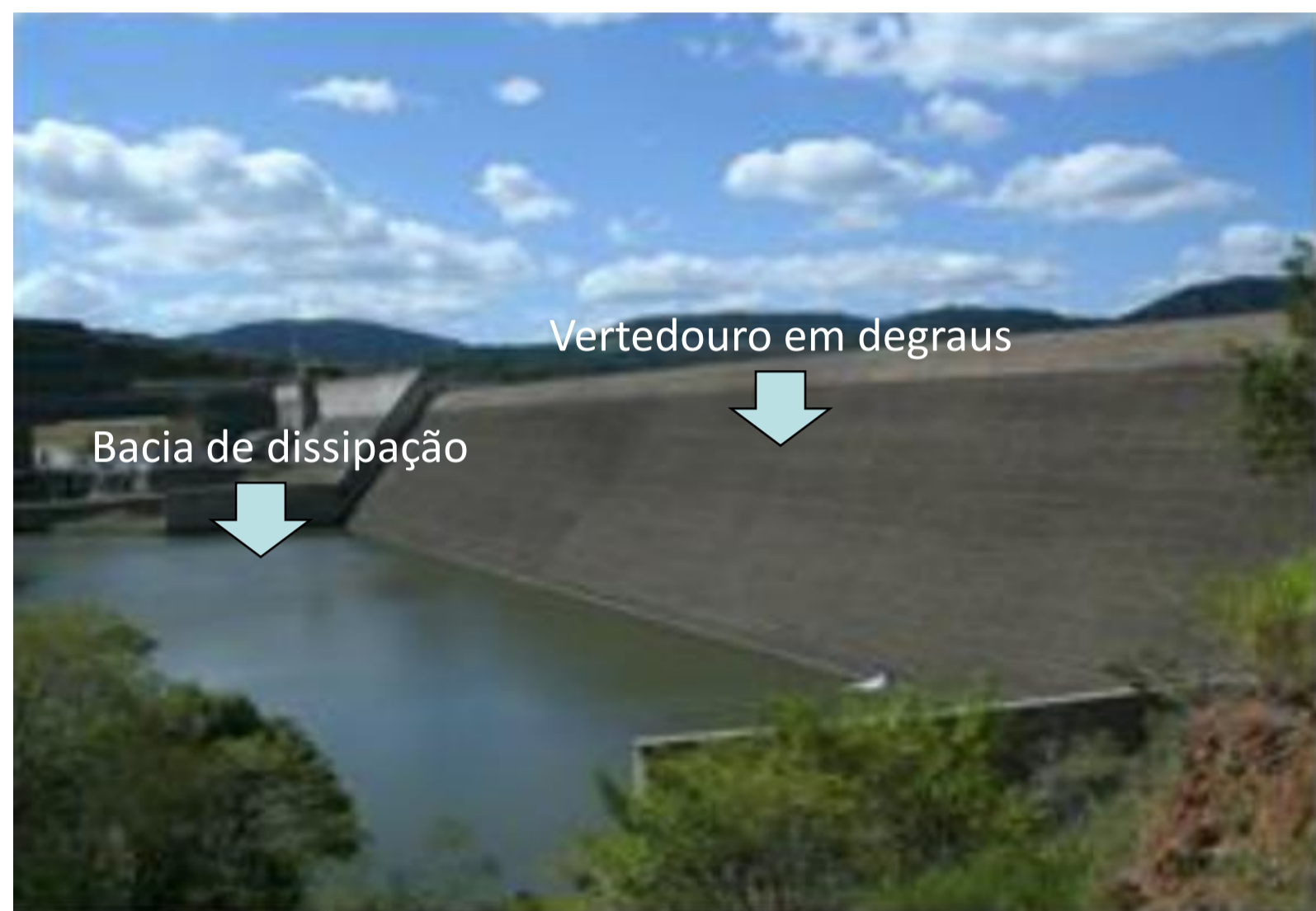
Figura 1: Sistema extravasador da barragem de Dona Francisca (RS).
